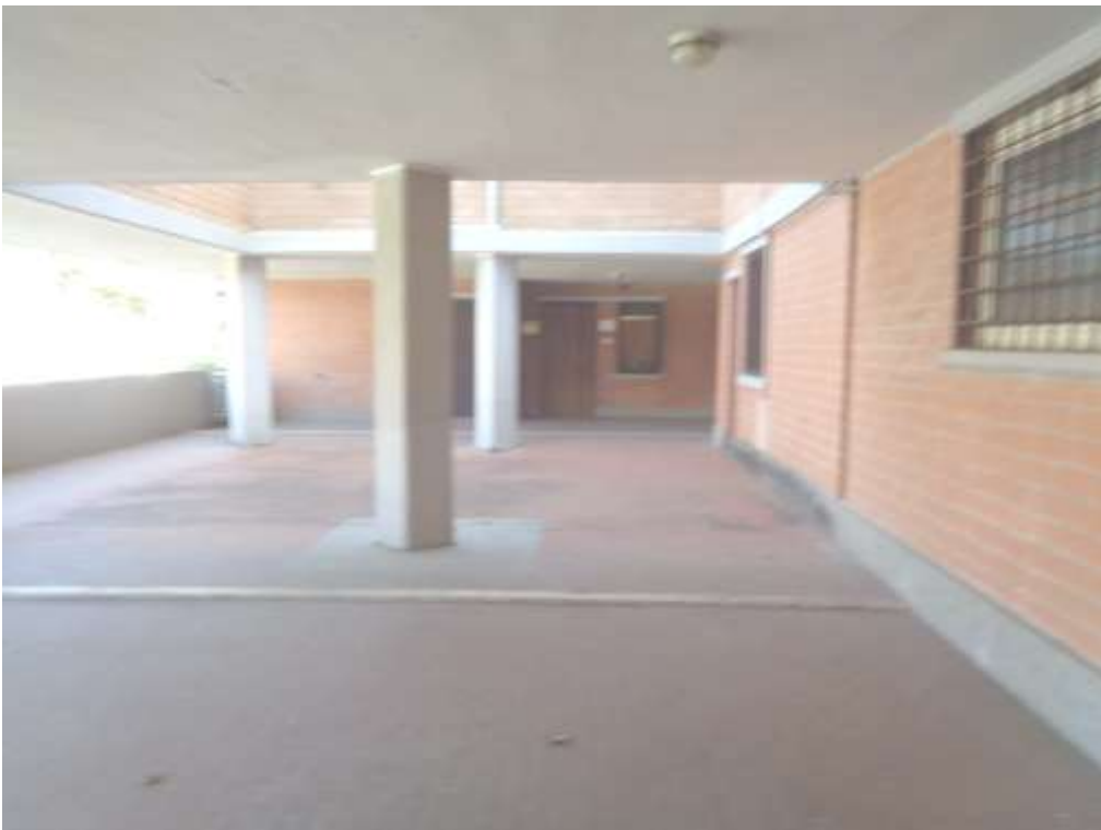
Area esterna coperta
