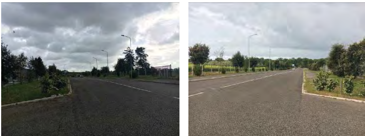
Via de la Comunella vista dall'ingresso al civico 180
