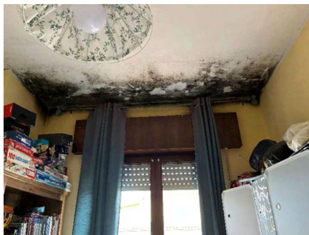
Le tracce di infiltrazioni/umidità rinvenute sul posto
