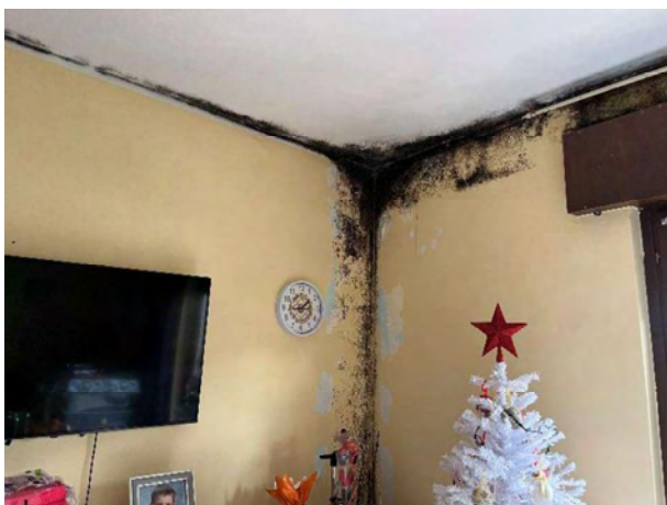
Le tracce di infiltrazioni/umidità rinvenute sul posto
