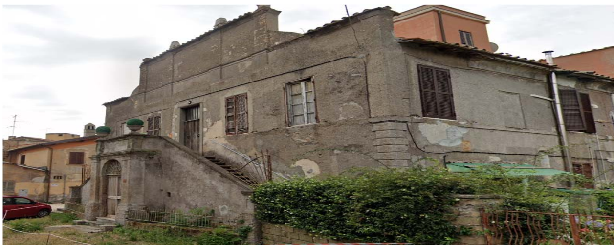
(CASA - STATO ATTUALE DEL PROSPETTO PRINCIPALE)
