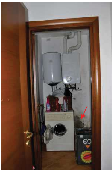
Macchie di umidità e intonaco esterno danneggiato
