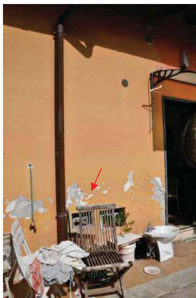
Macchie di umidità e intonaco esterno danneggiato
