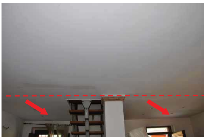
Ampliamento soffitta (realizzazione nuovo solaio)
