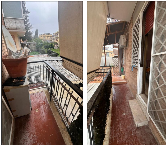
1- realizzazione balcone aggettante
