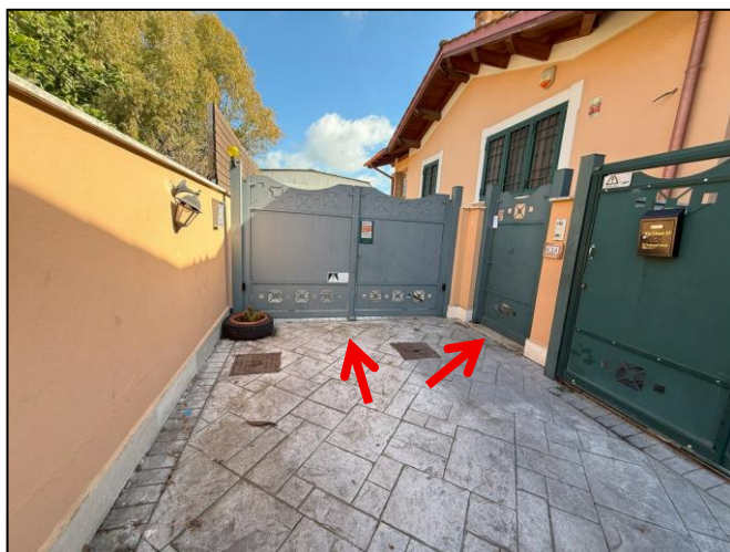
Accesso carrabile e pedonale al civ. 42/a
