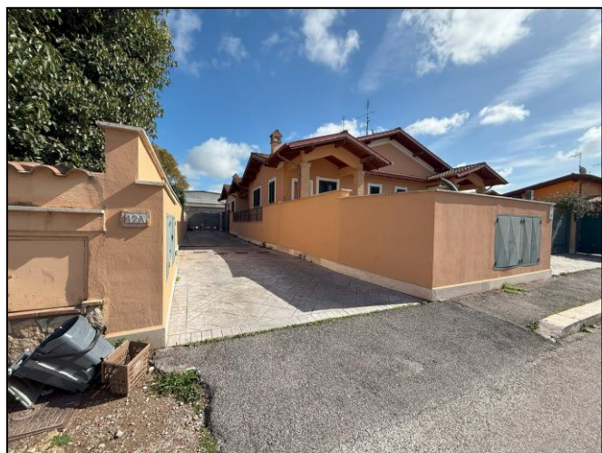
Accesso comune su Via Caiolo
