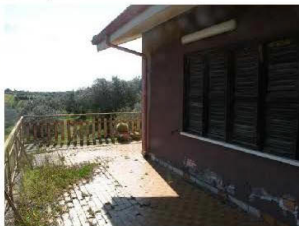
Gli spazi esterni all'abitazione al piano terreno
