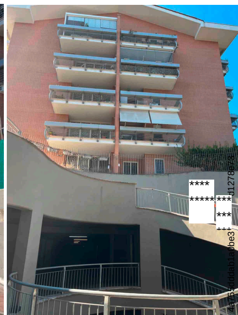
Foto 2 – testata edificio R12A
