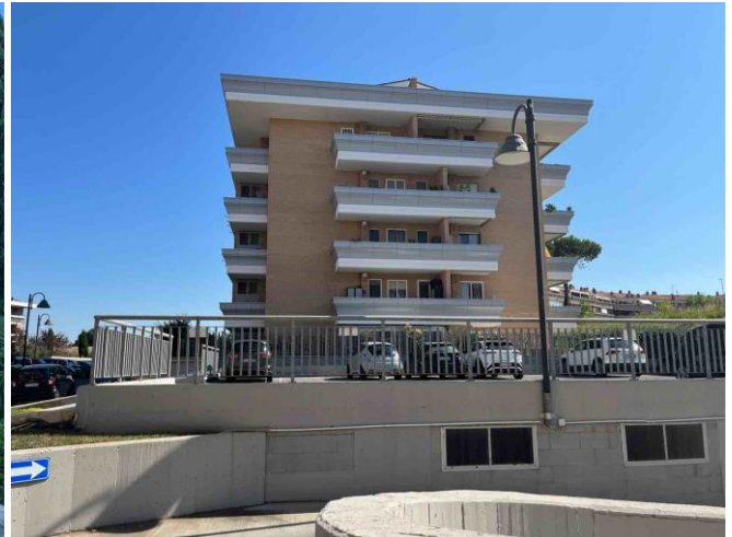
Foto 2 – testata edificio R12C con parcheggio scoperto
