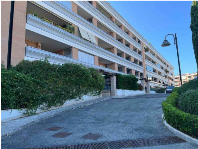
Foto 1 – prospetto longitudinale edificio R12C
