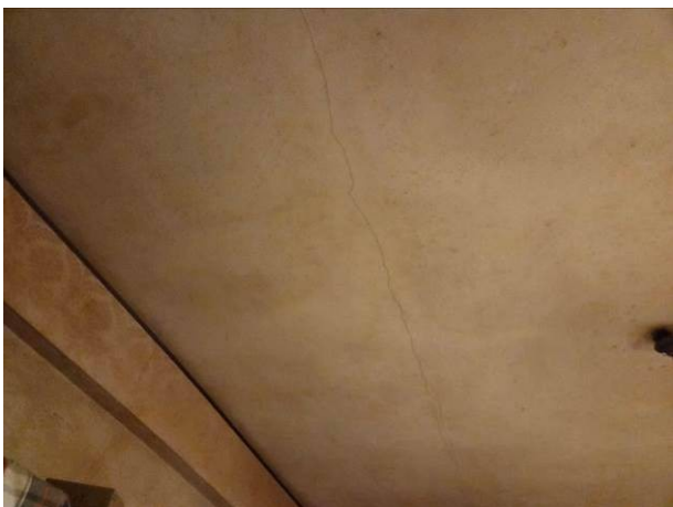
La cavillatura nel soffitto della stanza da letto e la pavimentazione dell'ingresso/disimpegno
