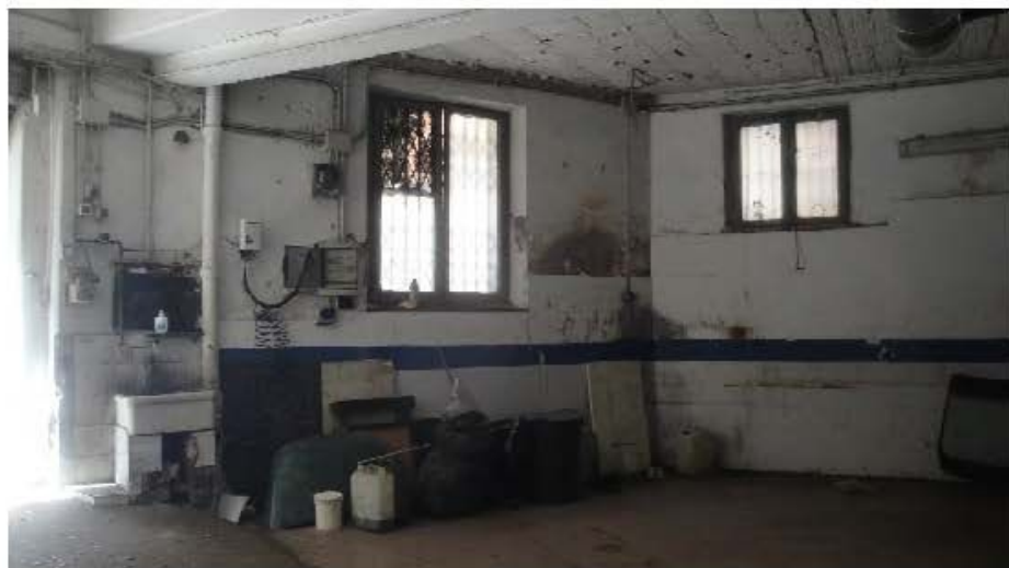
Foto 2 Vista interna del locale, pareti confinanti con la rampa
