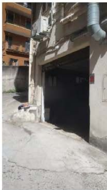
Foto 1 Accesso del locale dalla rampa
