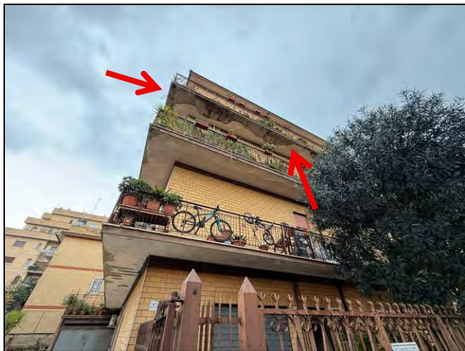
Vista dei sottobalconi
