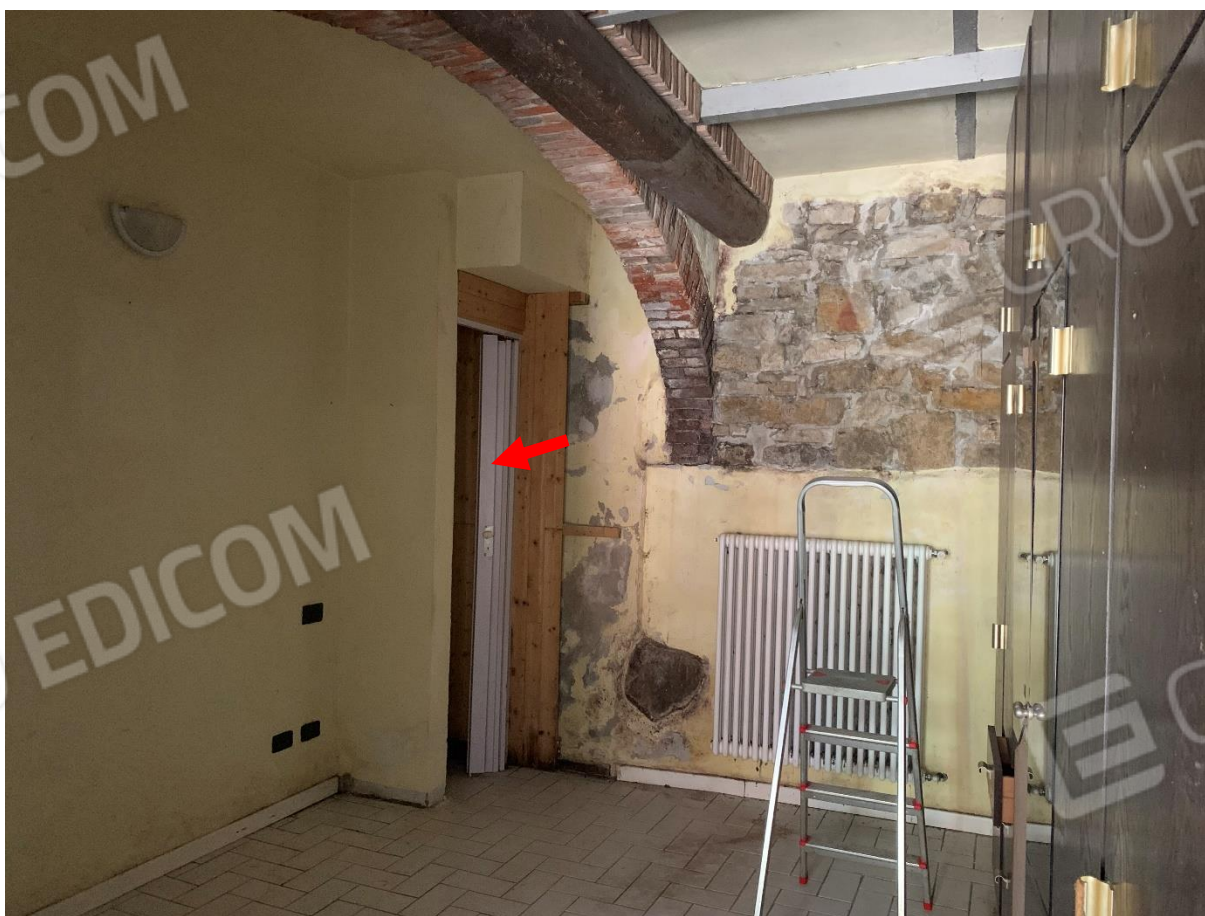
Vista camera con accesso intercapedine
