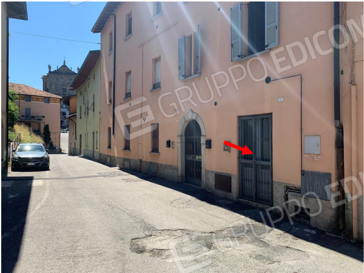
Vista accesso unità abitativa da via Tranquilla Frigerio
