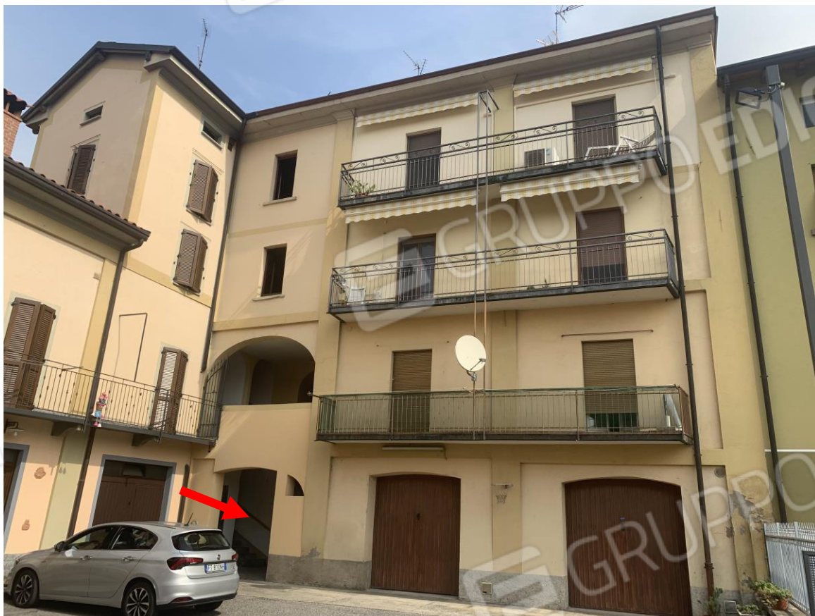
Vista fabbricato con accesso da cortile comune (piano sottostada)
