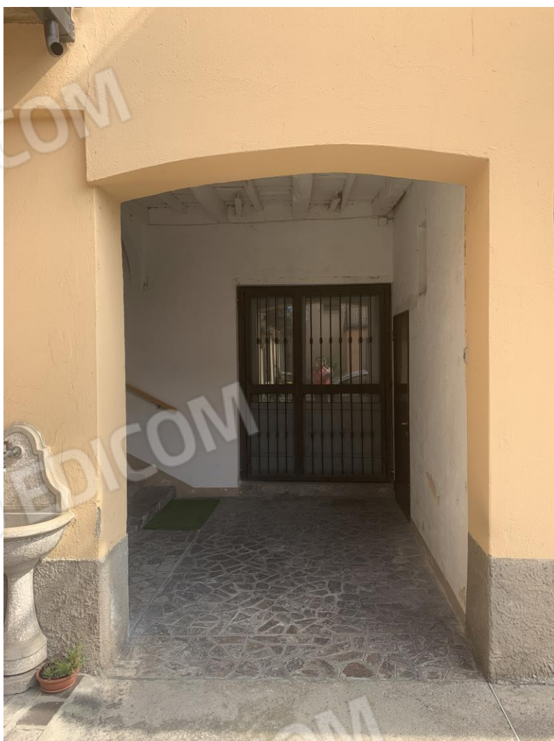
Vista portafinestra camera dal cortile comune (piano sottostada)
