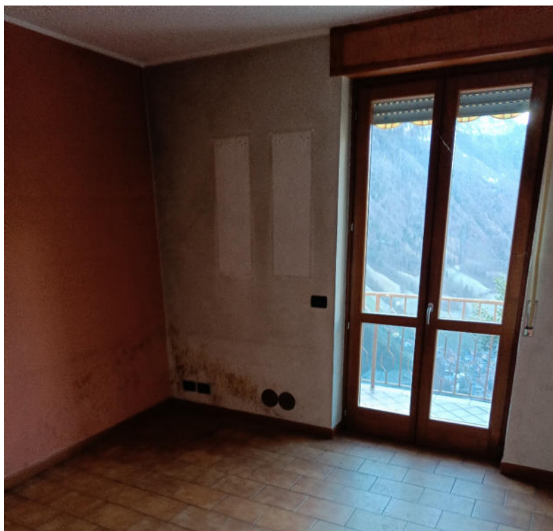
VEDUTA INTERNA IMMOBILE DI CUI AL MAPPALE N. 1071 SUB. 8
