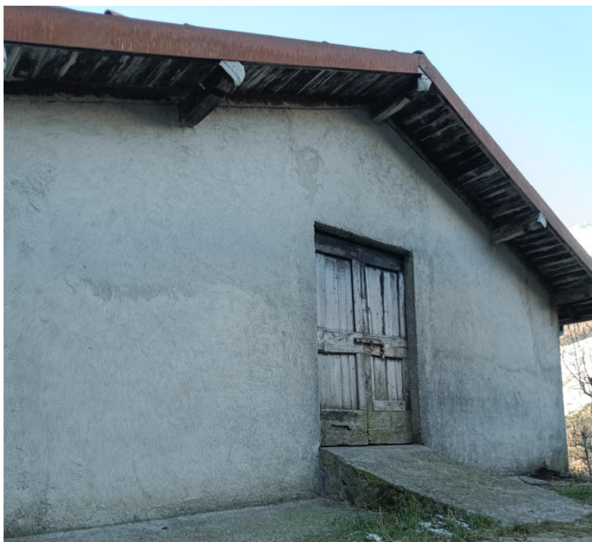
VEDUTA ESTERNA IMMOBILE DI CUI AL MAPPALE N. 1079
