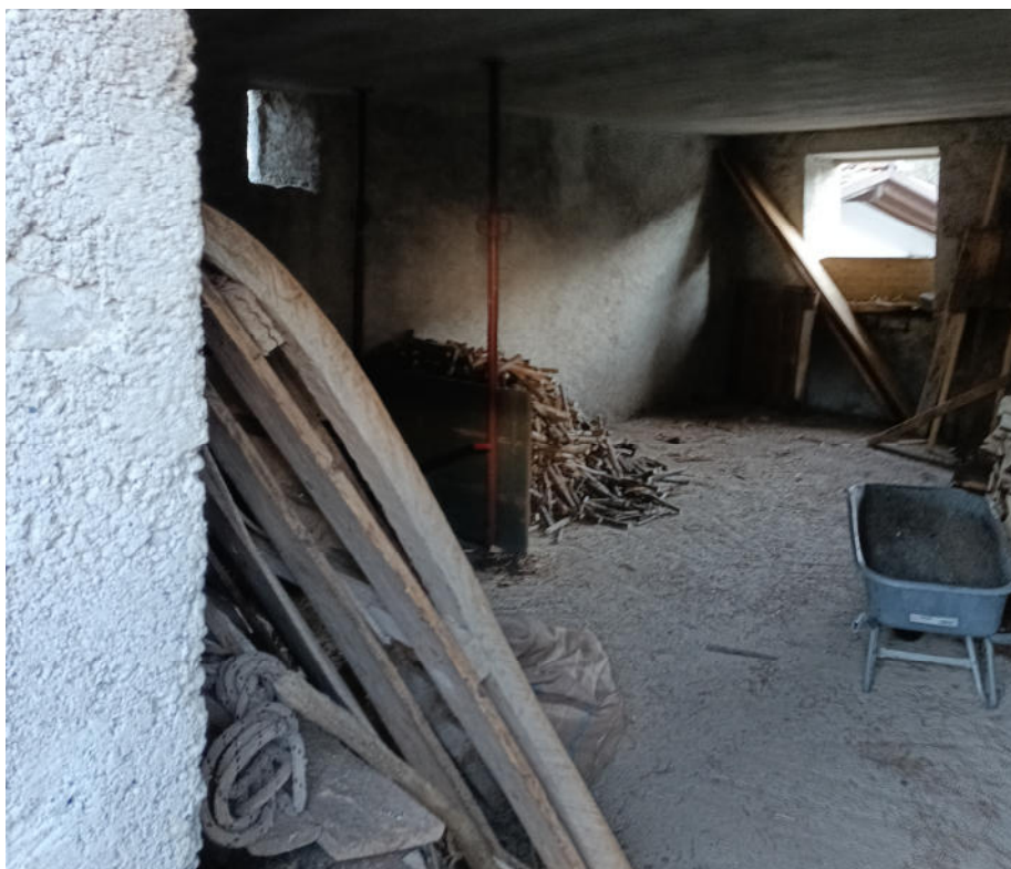
VEDUTA INTERNA IMMOBILE DI CUI AL MAPPALE N. 691 SUB. 3
