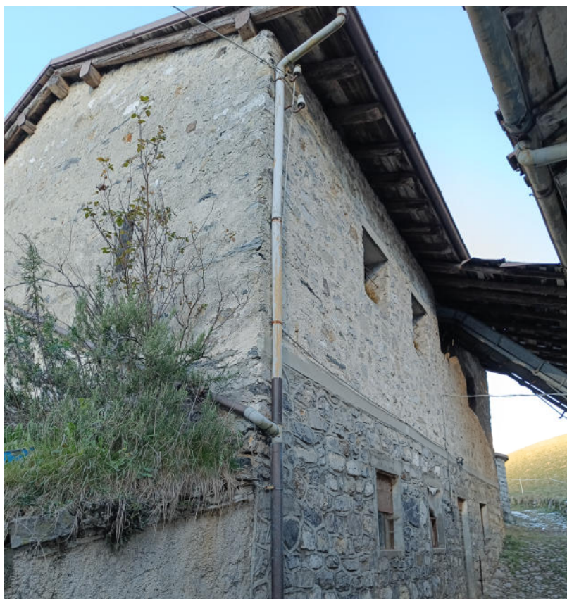
VEDUTA ESTERNA IMMOBILE DI CUI AL MAPPALE N. 3406
