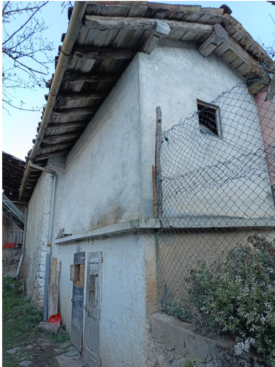
VEDUTA ESTERNA IMMOBILE DI CUI AL MAPPALE N. 1382
