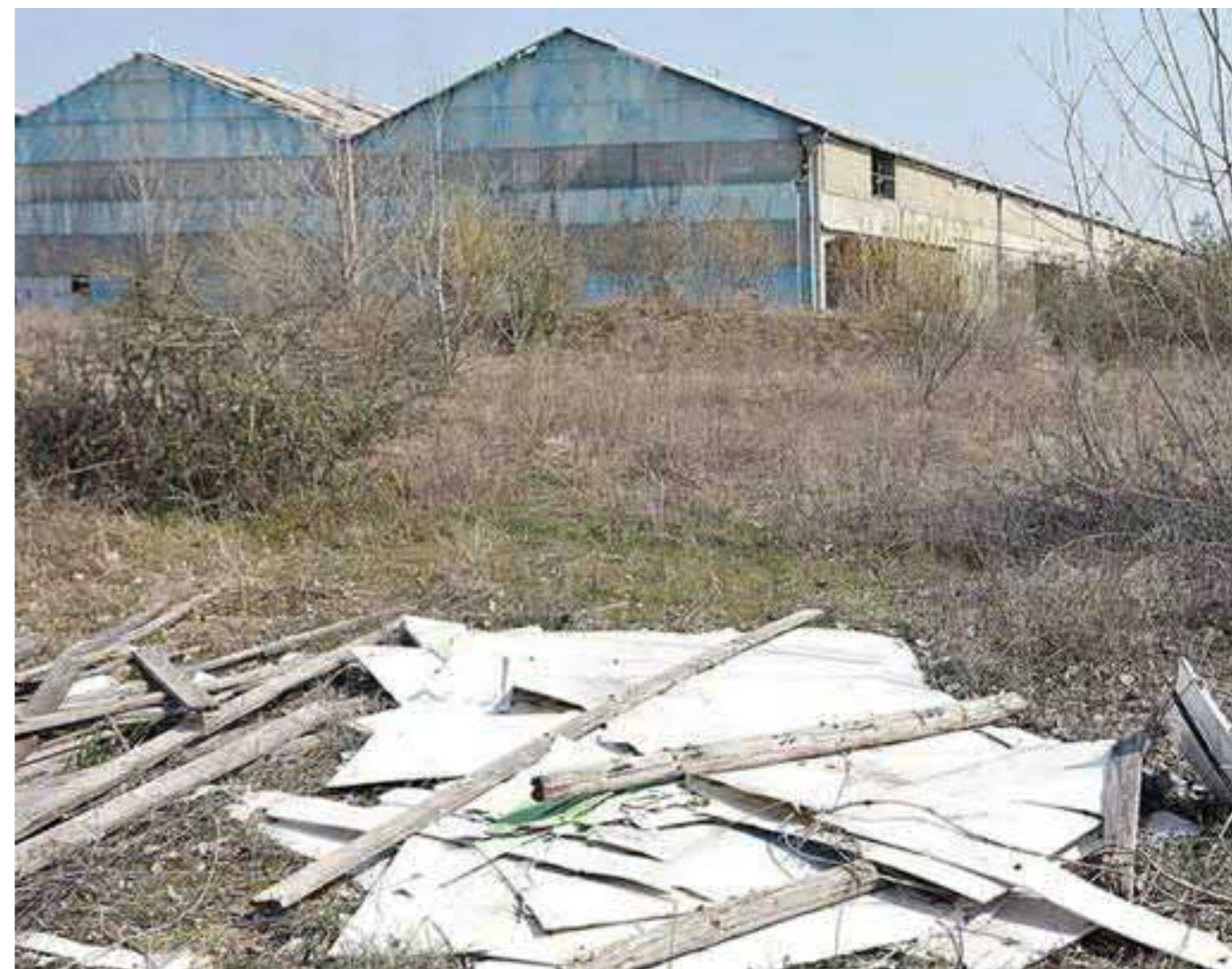
L'edificio lungo via Fusine prima della bonifica dal cemento amianto, ufficialmente conclusa nel 2019
