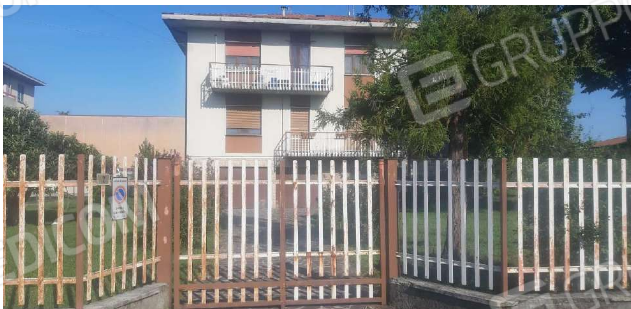
Foto n.2) Veduta edificio residenziale bifamiliare da via Padre Lazzaroni 2
