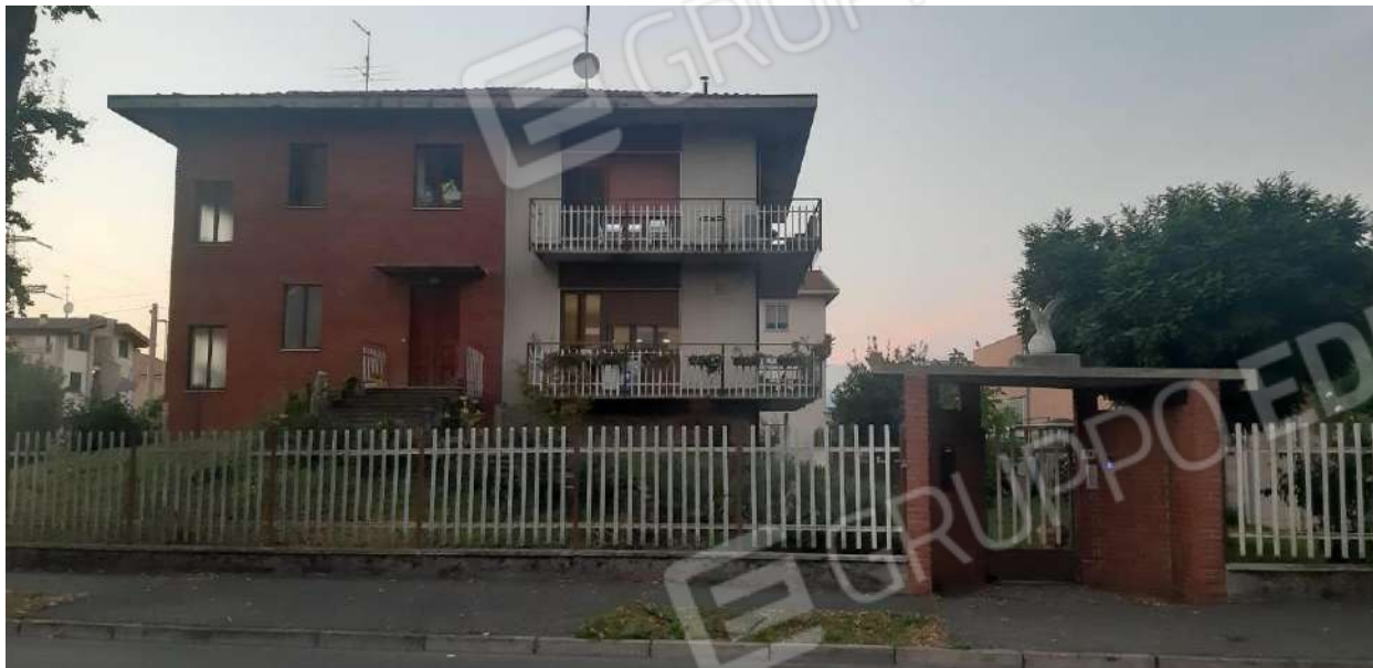
Foto n.1) Veduta edificio residenziale bifamiliare da viale Brembo 20
