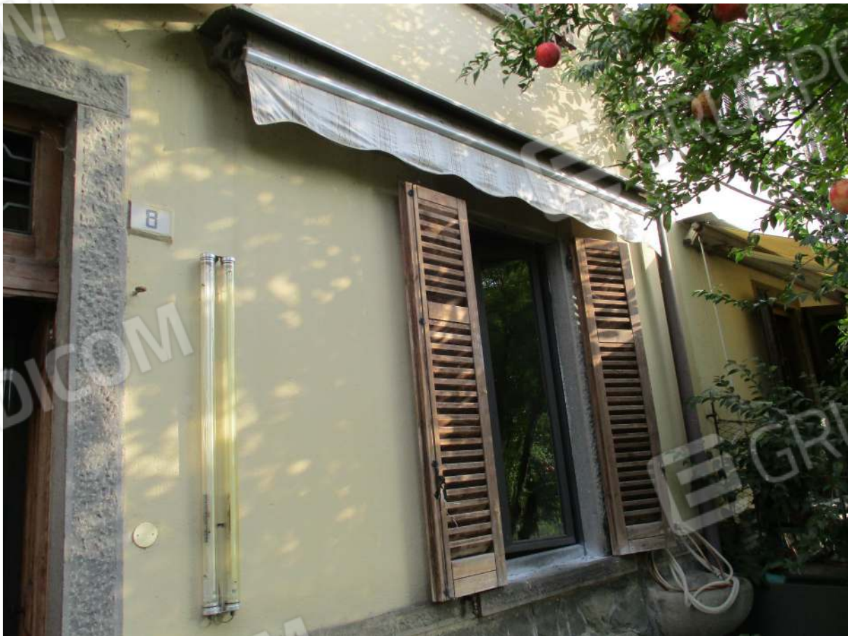
Fig. 12 – Vista delle tende da sole installate sulle finestre del piano terra
