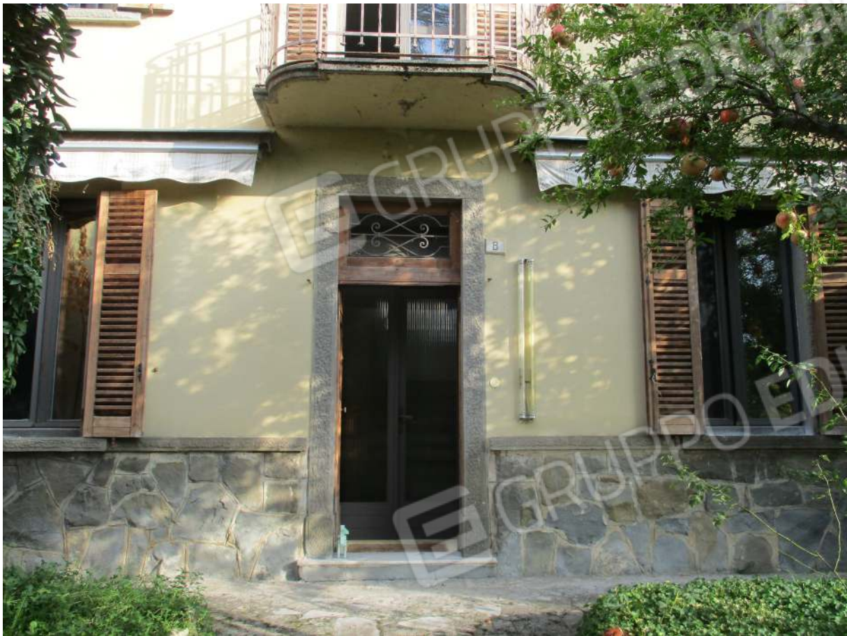
Fig. 11 – Vista del piano terra dell'immobile
