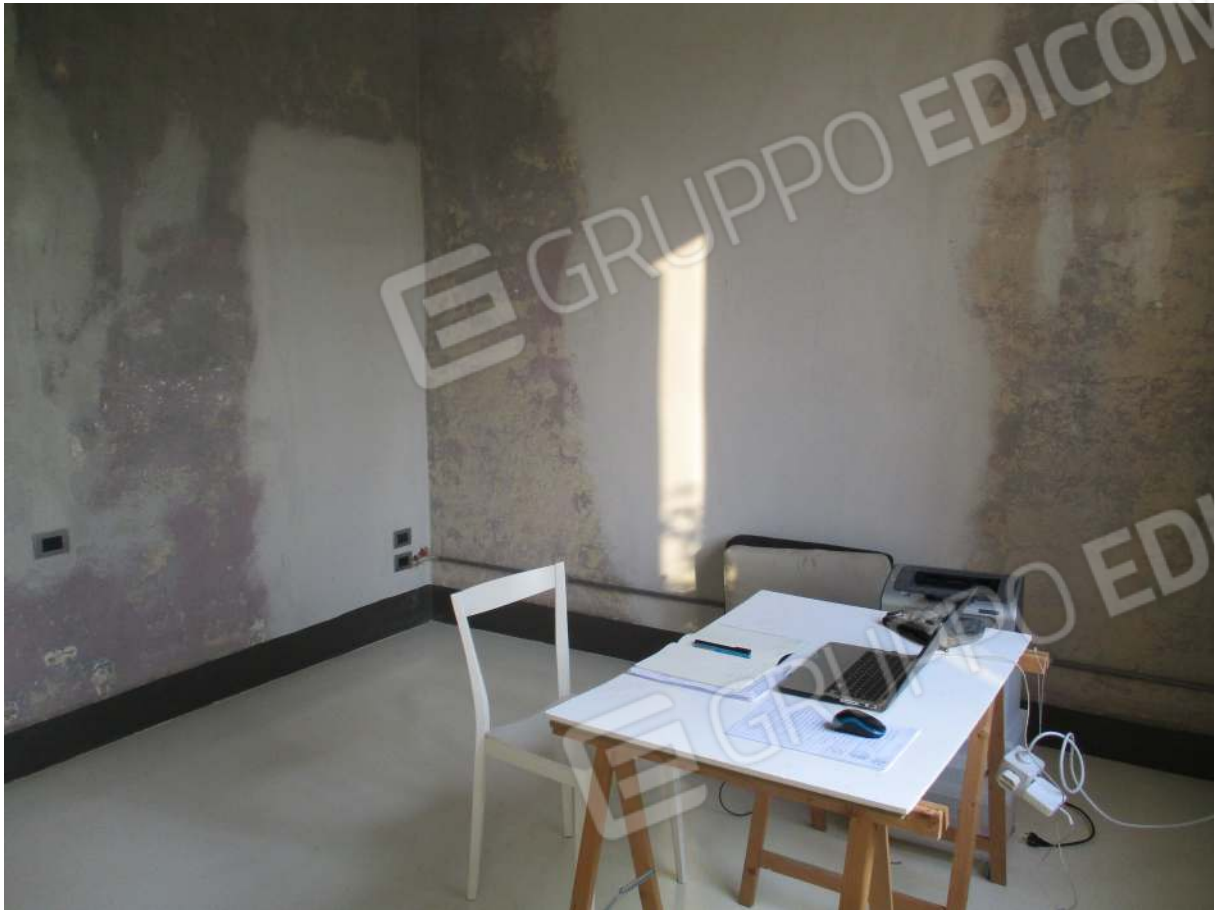
Fig. 32 – Vista d'insieme della camera posta nell'angolo sud-est
