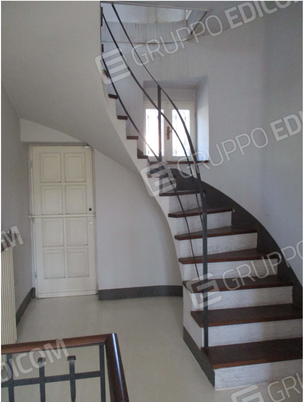
Fig. 40 – Vista dell'ingresso secondario a P.1° con a fianco la scala che conduce al P. sottotetto
