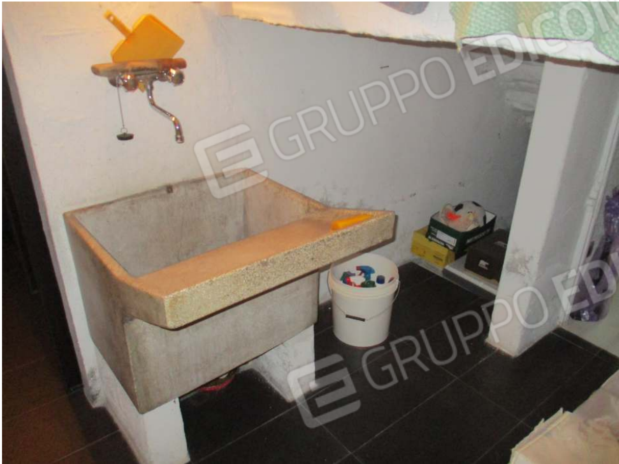
Fig. 25 – Vista del lavatoio installato nel locale ripostiglio/lavanderia adiacente la cucina
