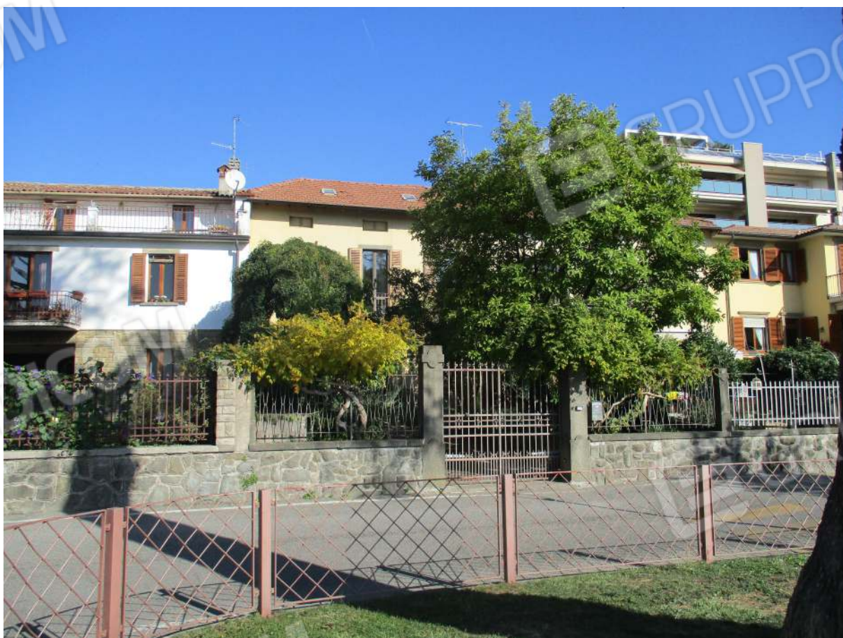
Fig. 6 – Vista d'insieme dell'immobile da Viale Orgnieri (prospetto sud)
