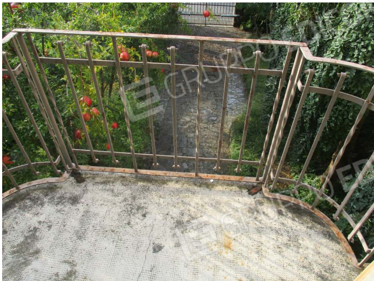
Fig. 30 – Vista del balcone al P.1° (lato sud)
