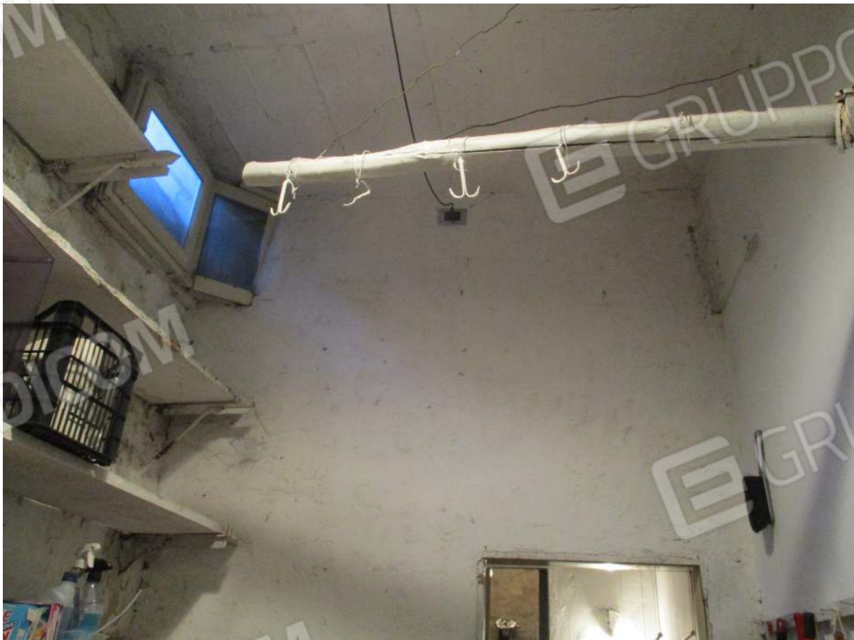
Fig. 26 – Vista del sopraaluce presente nella cantina
