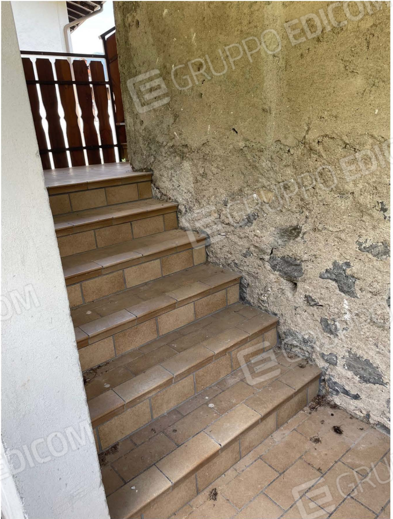
Figura 2 – Scala d'ingresso all'abitazione.
