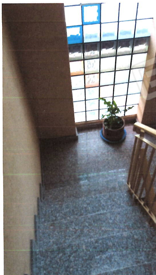
Scala accesso al piano 2°
