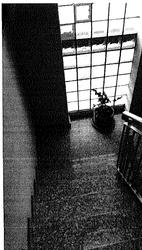
Scala accesso al piano 2°
