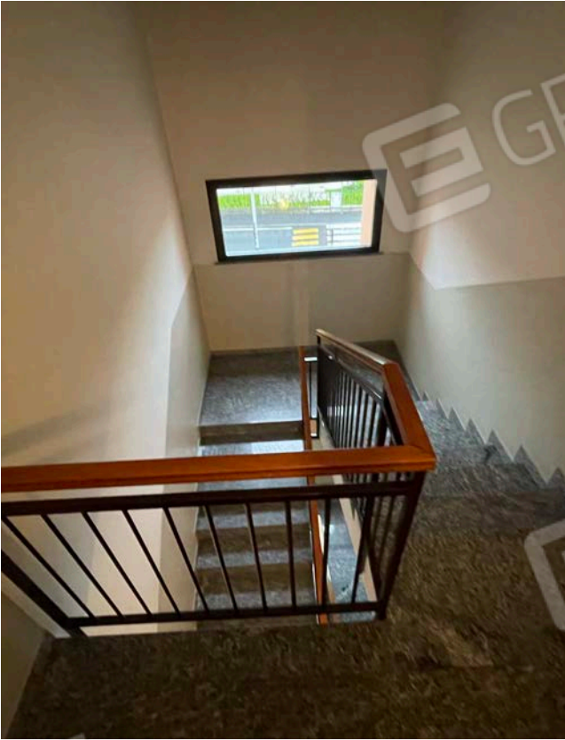
Fig. 29 Vano scala comune
