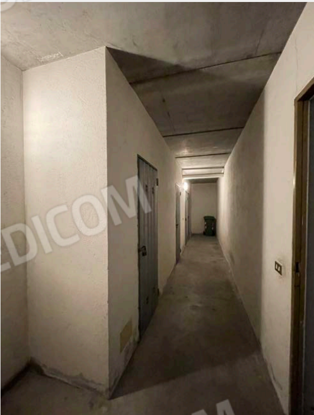
Fig. 31 Percorso comune interno piano seminterrato Vista verso i locali cantina
