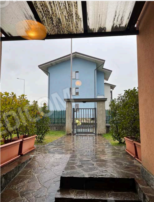
Fig. 31 Percorso pedonale comune Vista verso il cancellone pedonale esterno
