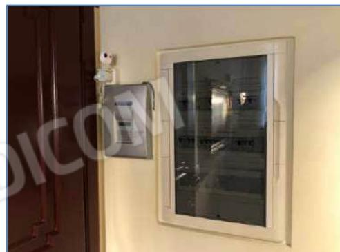
Foto 4.29: Quadro elettrico e centralina allarme
