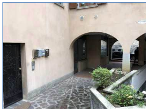
Foto 2.3: Ingresso condominio e ingresso negozio
