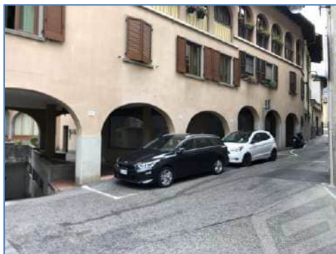
Foto 2.1: Prospetto su Via Roma
