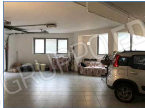
Foto 3.4: Finestre angolo sud/est – sud/ovest
