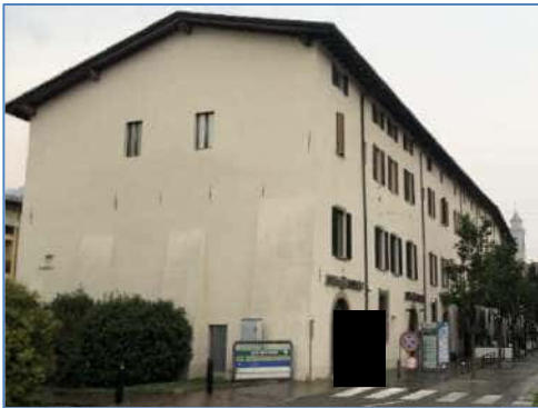
Foto 4.1: Fabbricato via Mazzini
