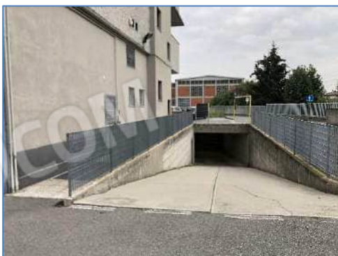
Foto 7.18: rampa di accesso al PS1
