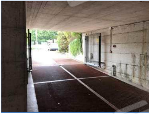
Foto 4.31: rampa di accesso vista dall'interno
