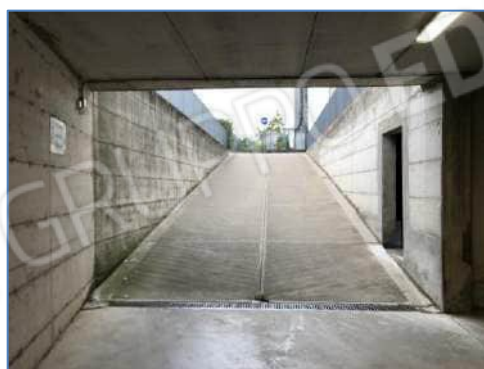
Foto 8.16: rampa di accesso vista dall'interno
