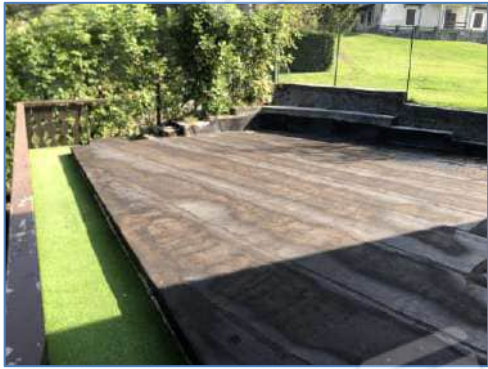
Foto 1.33: Terrazzo P.1 a nord/est (sopra autorimessa)
