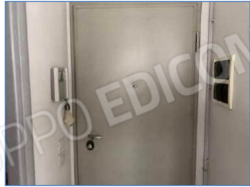
Foto 3.10: porta vano scala, quadro elettrico e videocitofono
