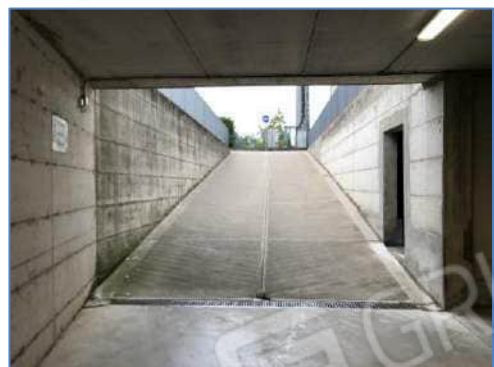
Foto 7.19: rampa di accesso vista dall'interno
