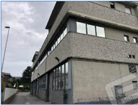
Foto 6.1: esterno del fabbricato lato
