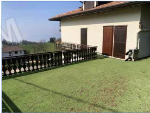
Foto 1.29: terrazzo al P.1 a sud/est
