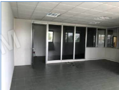
Foto 6.13 parete di separazione ala nord dal corridoio
