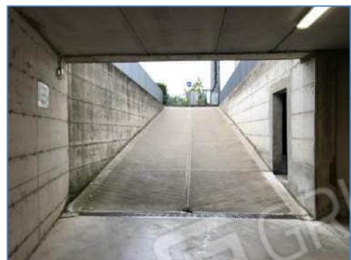
Foto 7.19: rampa di accesso vista dall'interno
