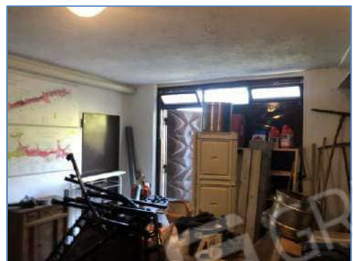
Foto 1.40: Porta autorimessa vista dall'interno
