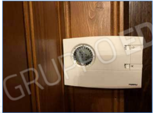
Foto 1.28: cronotermostato al P.1
