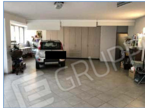
Foto 3.6: parete nord/ovest di confine
