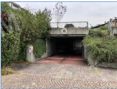
Foto 5.1: rampa di accesso alle autorimesse
