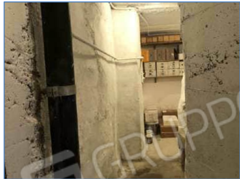
Foto 1.46: Altra vista della cantina
