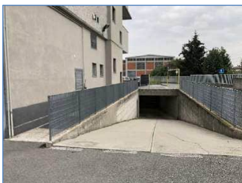
Foto 8.15: rampa di accesso al PS1
