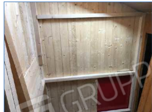
Foto 1.38: Nuova parete del bagno al P.2
