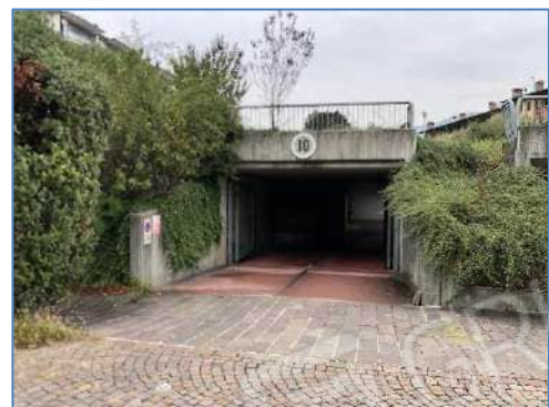
Foto 4.30: rampa di accesso alle autorimesse
