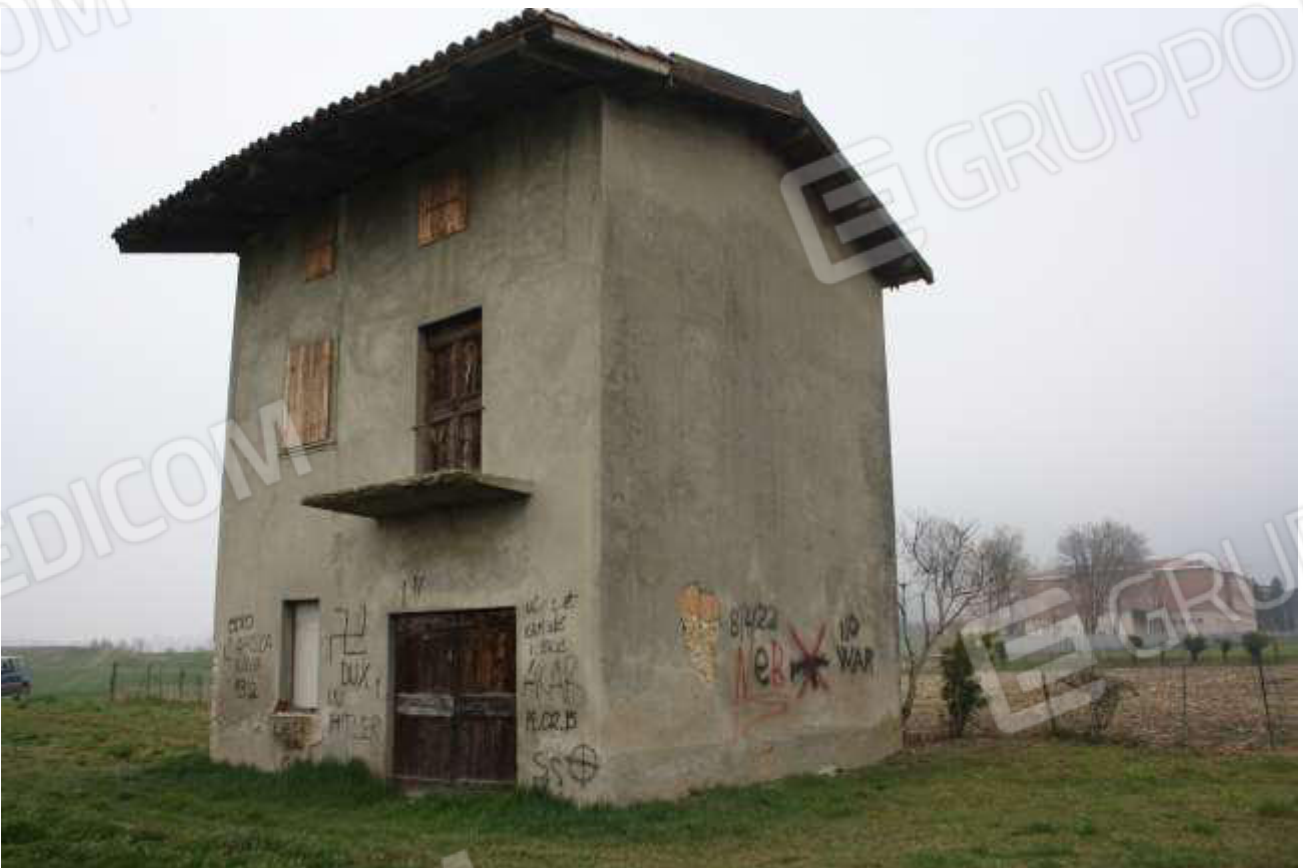
Fabbricato a destinazione agricola esistente sulla particella 108 già in mappa.
