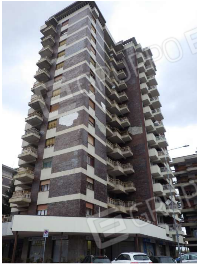
1. Prospetto in lato sud-est.
