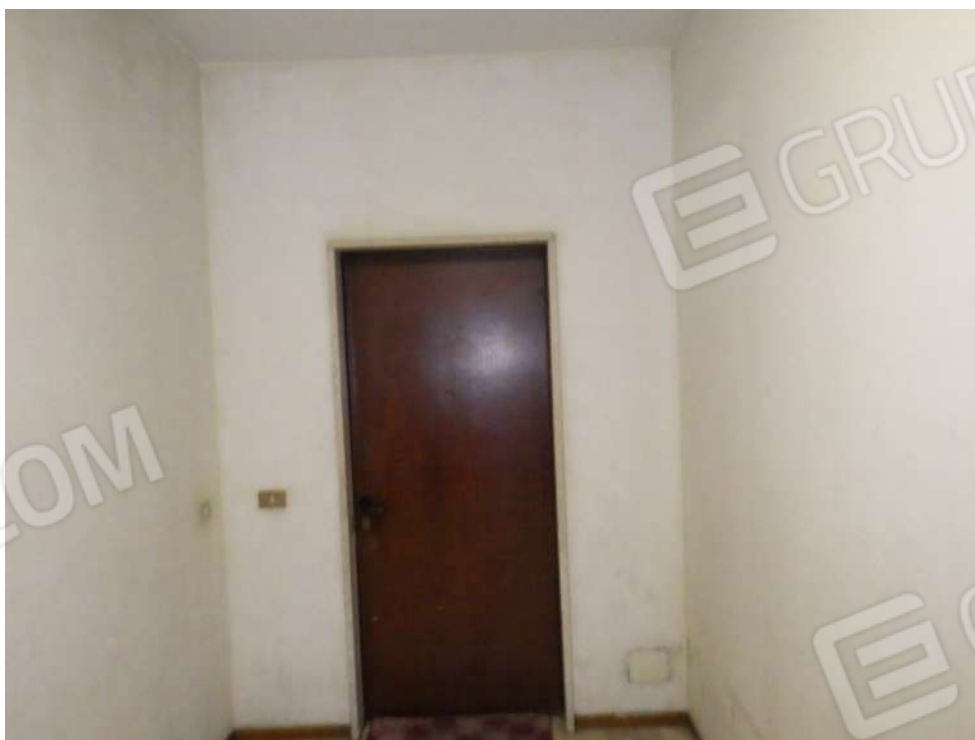
12. Ingresso unità immobiliare a piano quarto.
