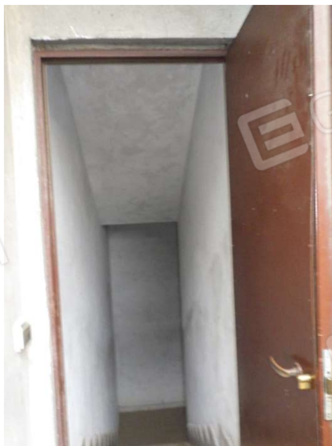
28. Accesso condominiale al piano interrato.
