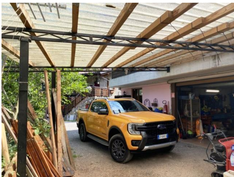
Esterno con tettoia da demolire
