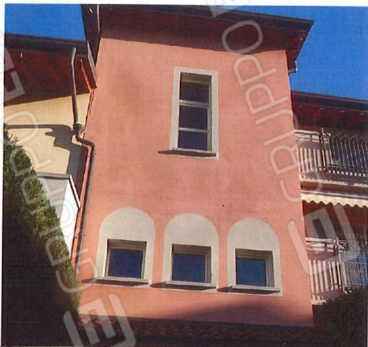
13 id. 10, il vano scala
