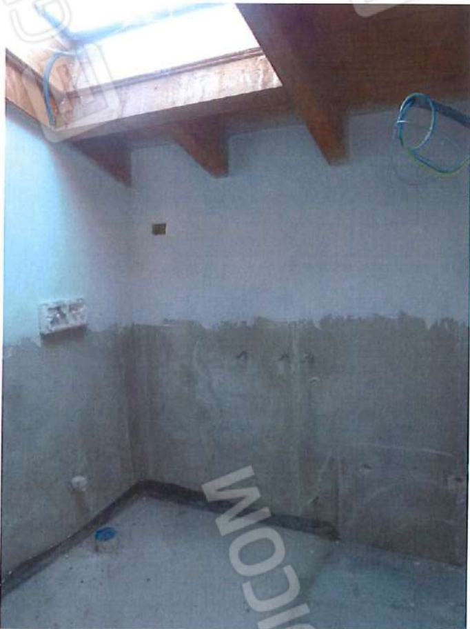
30 il bagno con inf. sotto doccia eseguiti
