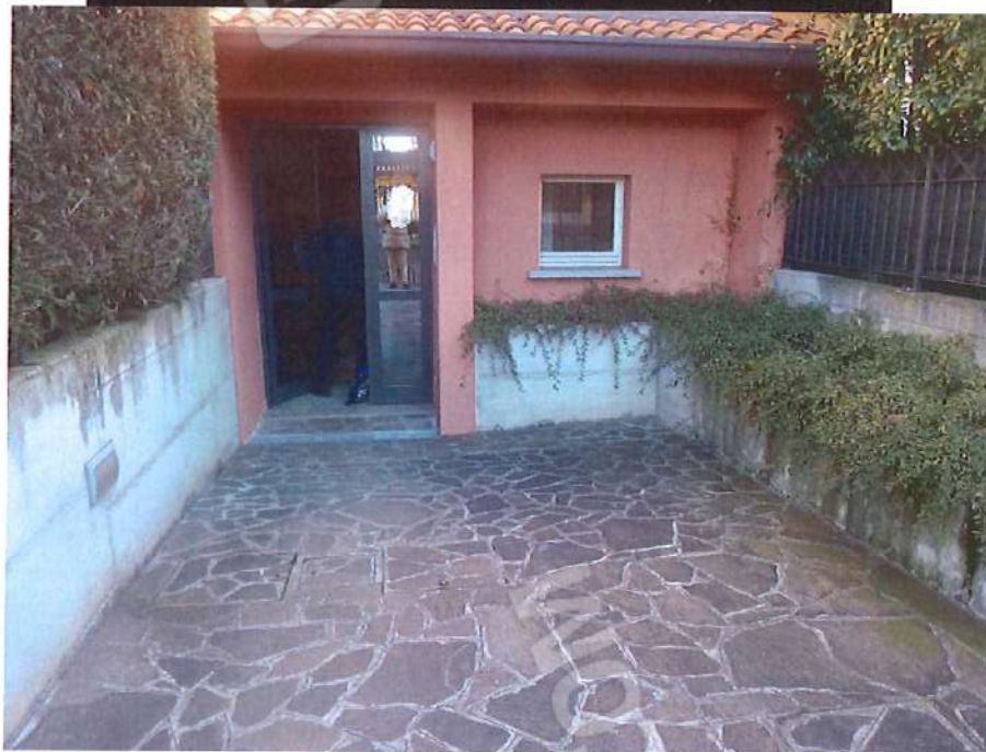
14 l'ingr. al vano scala
