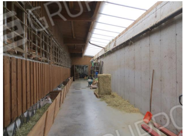
Interno stalla con muro contro terra
