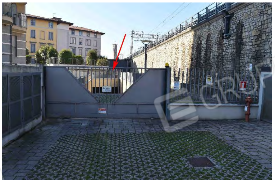
Cortile Nord, accesso carrale interrato.
