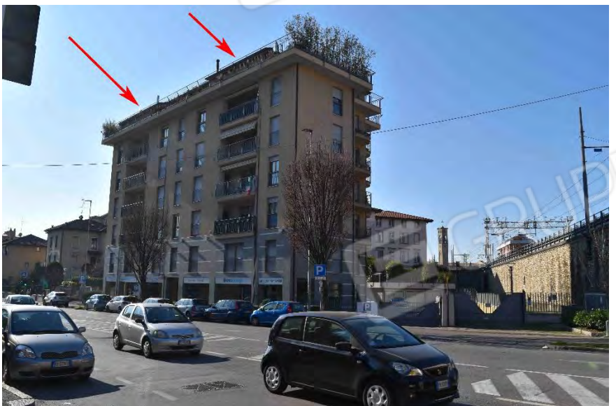
Prospetto Est, angolo Nord.
