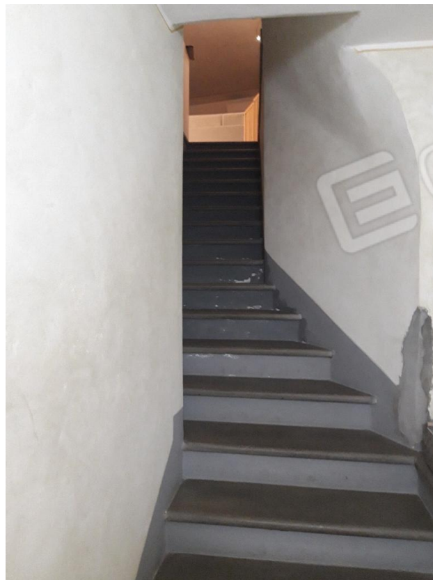
Scale con vista da piano interrato
