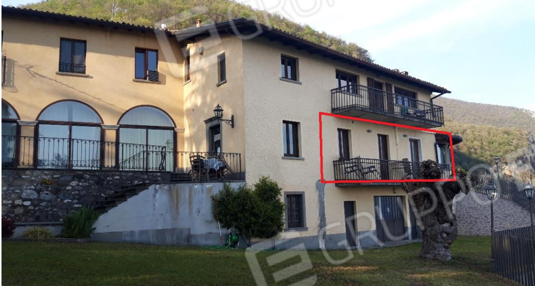
Vista esterna da sud
