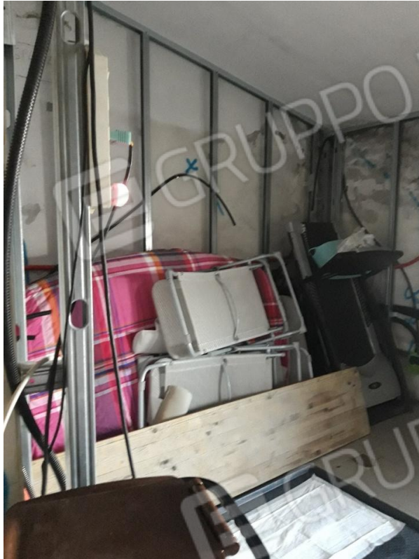
Vano 1 in fase di ristrutturazione
