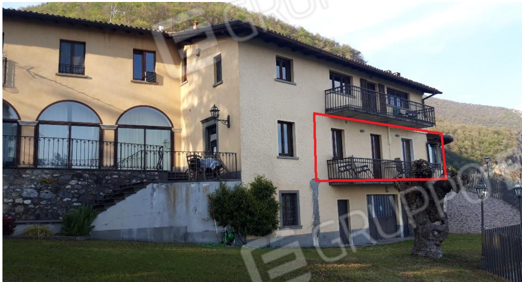
Vista esterna da sud
