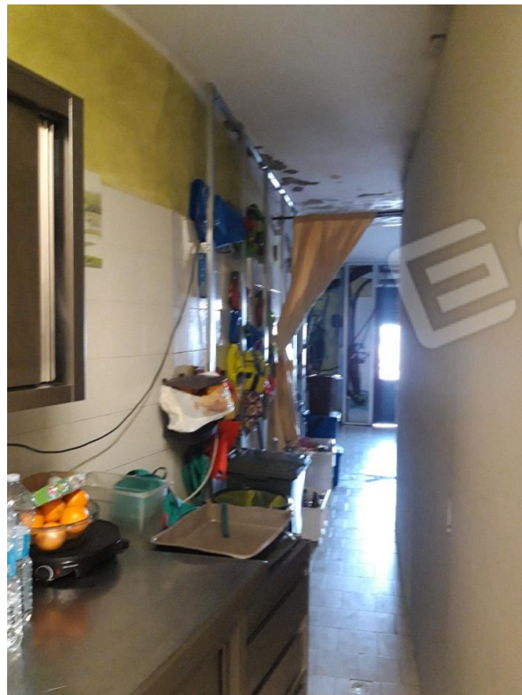
Vano 2 in fase di ristrutturazione
