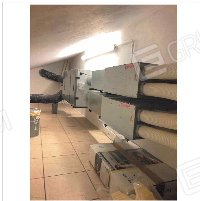
L'intercapedine adibita a vano tecnico
