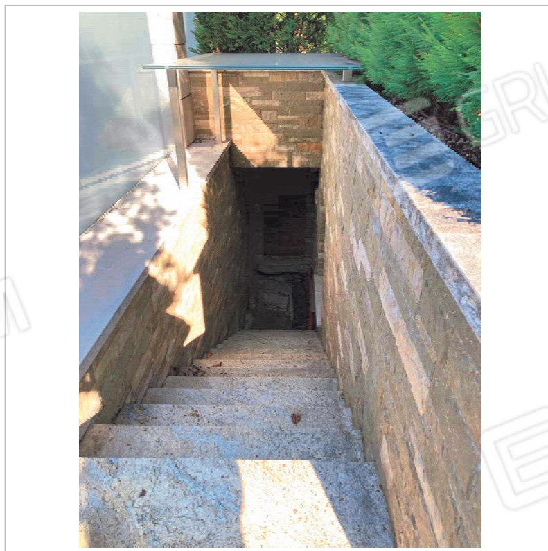
La scala che collega l'interrato alla piscina
