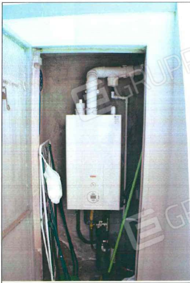
[9] Vista del vano tecnico con la caldaia privata x risc./acs;
