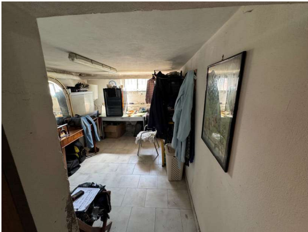
Foto 09 – Piano seminterrato cantina
