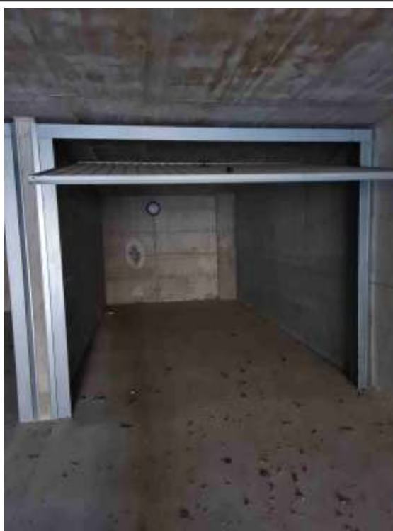
A-7_Fot. 12 -Autorimessa 7 -sub. 32
