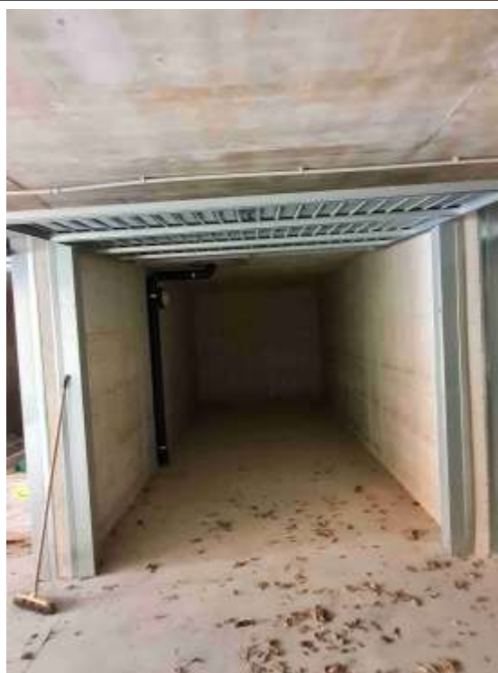
A-10_Fot. 16 -Autorimessa 3 -sub. 28
