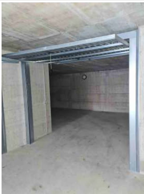
A-6_Fot. 13 -Autorimessa 6 -sub. 31
