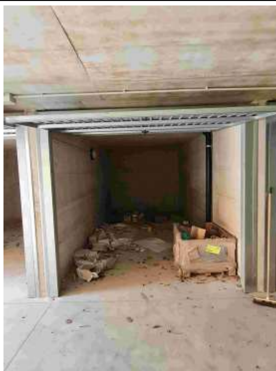
A-5_Fot. 09 -Autorimessa 2 -sub. 27
