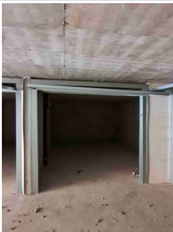
A-8_Fot. 11 -Autorimessa 5 -sub. 30
