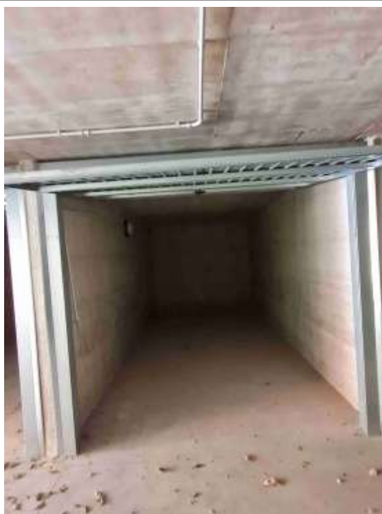
A-9_Fot. 11 -Autorimessa 4 -sub. 29
