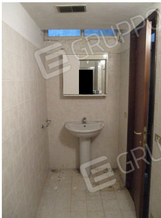
Fig. 37 – Vista del bagno al P. seminterrato
