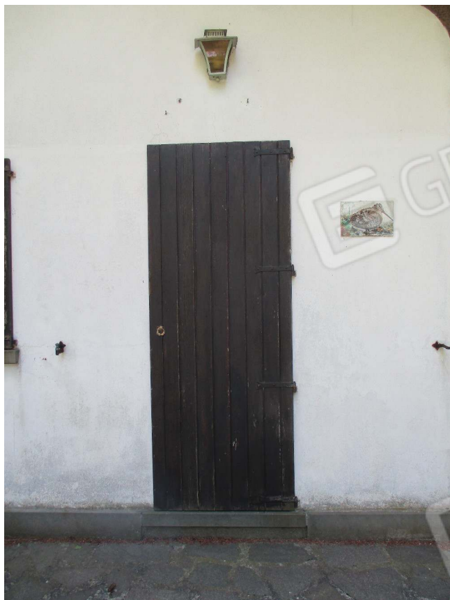
Fig. 13 – Vista esterna porta d'ingresso al P.T.
