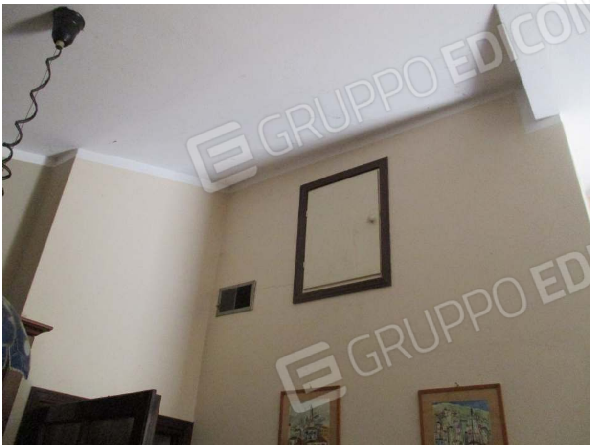
Fig. 28 – Vista dell'accesso al ripostiglio nel sottotetto
