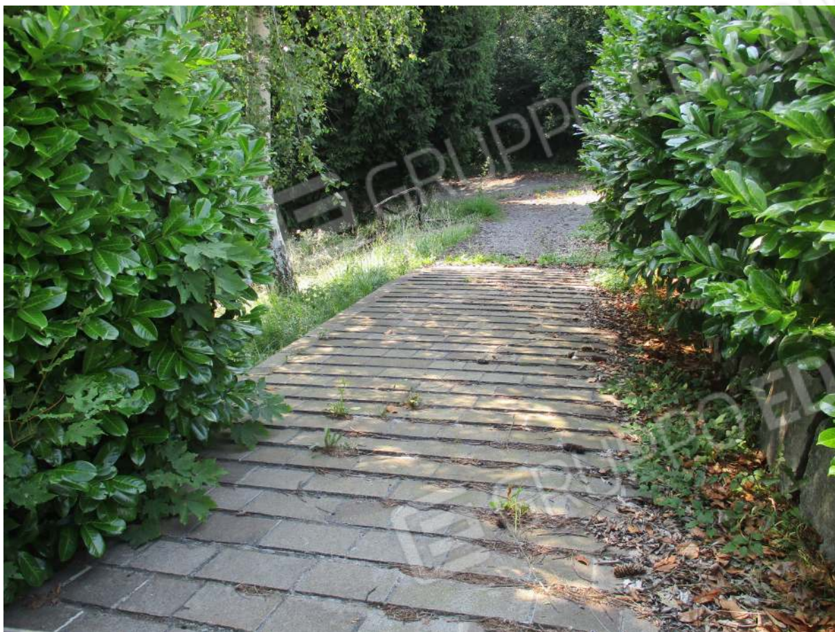
Fig. 3 – Vista della rampa carrabile (lato est)
