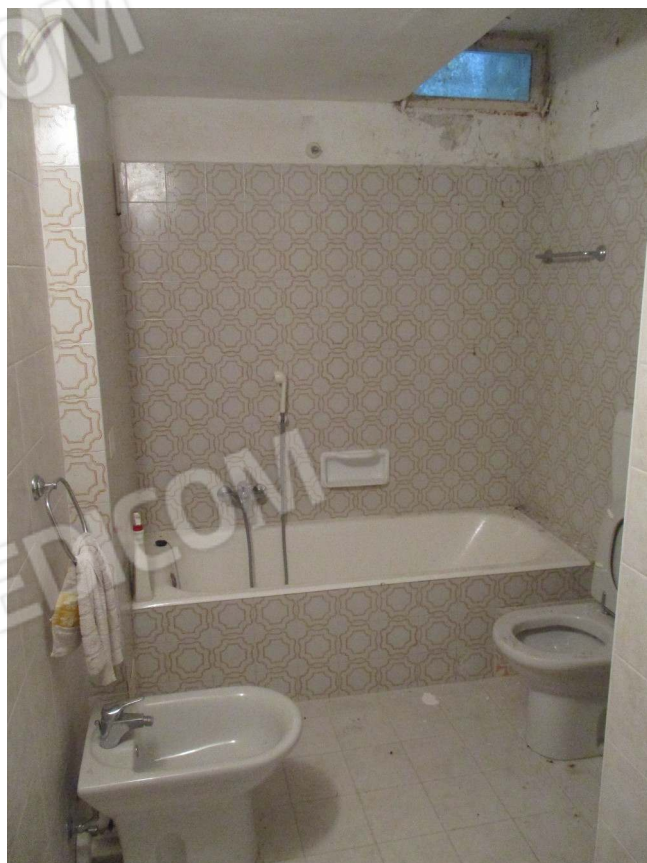
Fig. 36 – Vista del bagno al P. seminterrato
