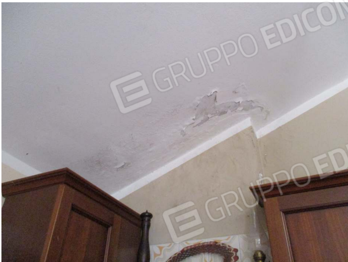
Fig. 16 – Vista di un'infiltrazione d'acqua dalla copertura sul soffitto della cucina
