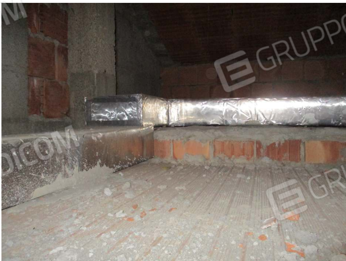
Fig. 29 – Vista interna del ripostiglio nel sottotetto
