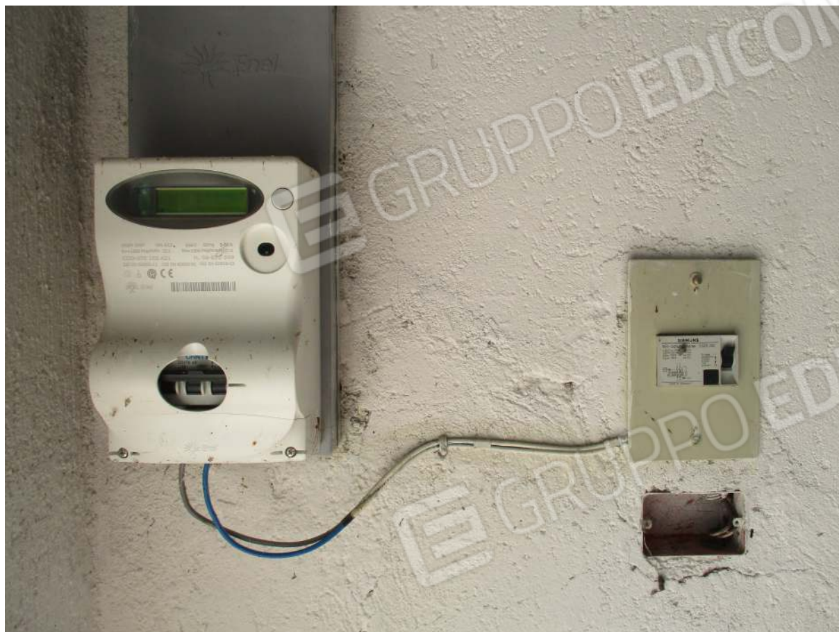
Fig. 43 – Vista del contatore Enel installato nel box al P. seminterrato
