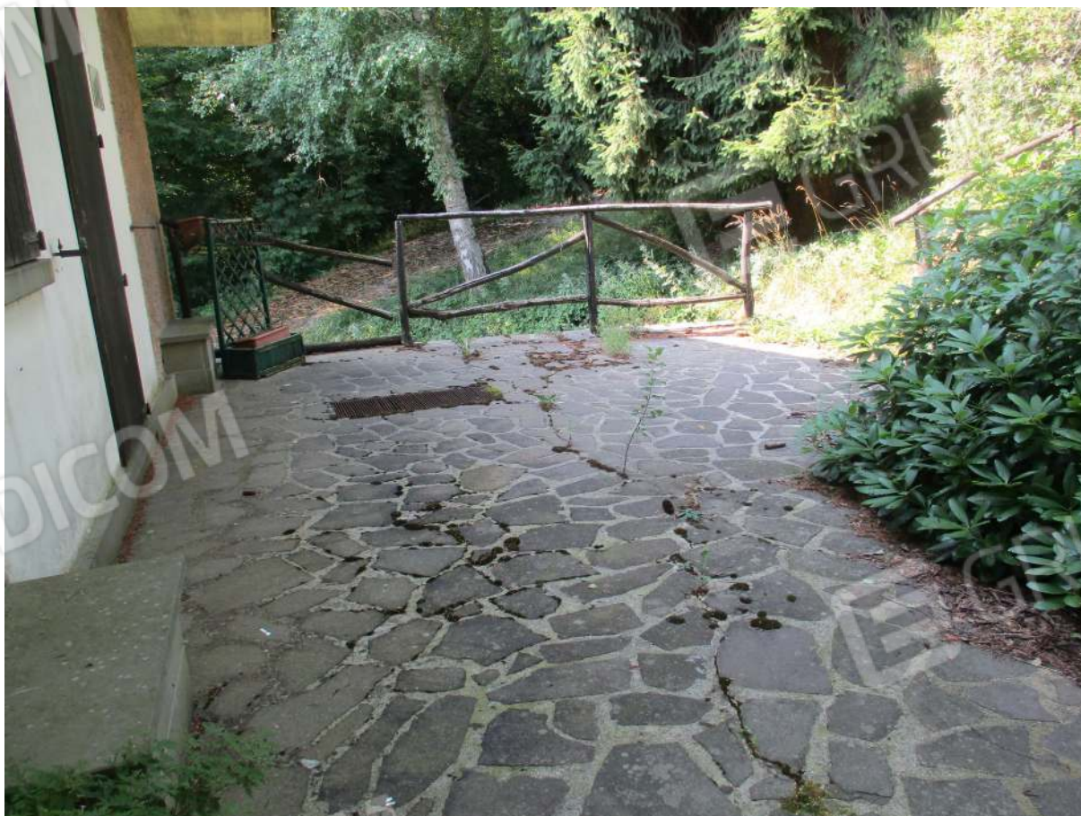
Fig. 8 – Vista del lastricato sul lato est dell'edificio
