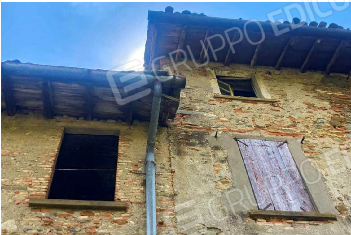
Tegole sporgenti oltre il canale di gronda e canali intasati dal muschio
