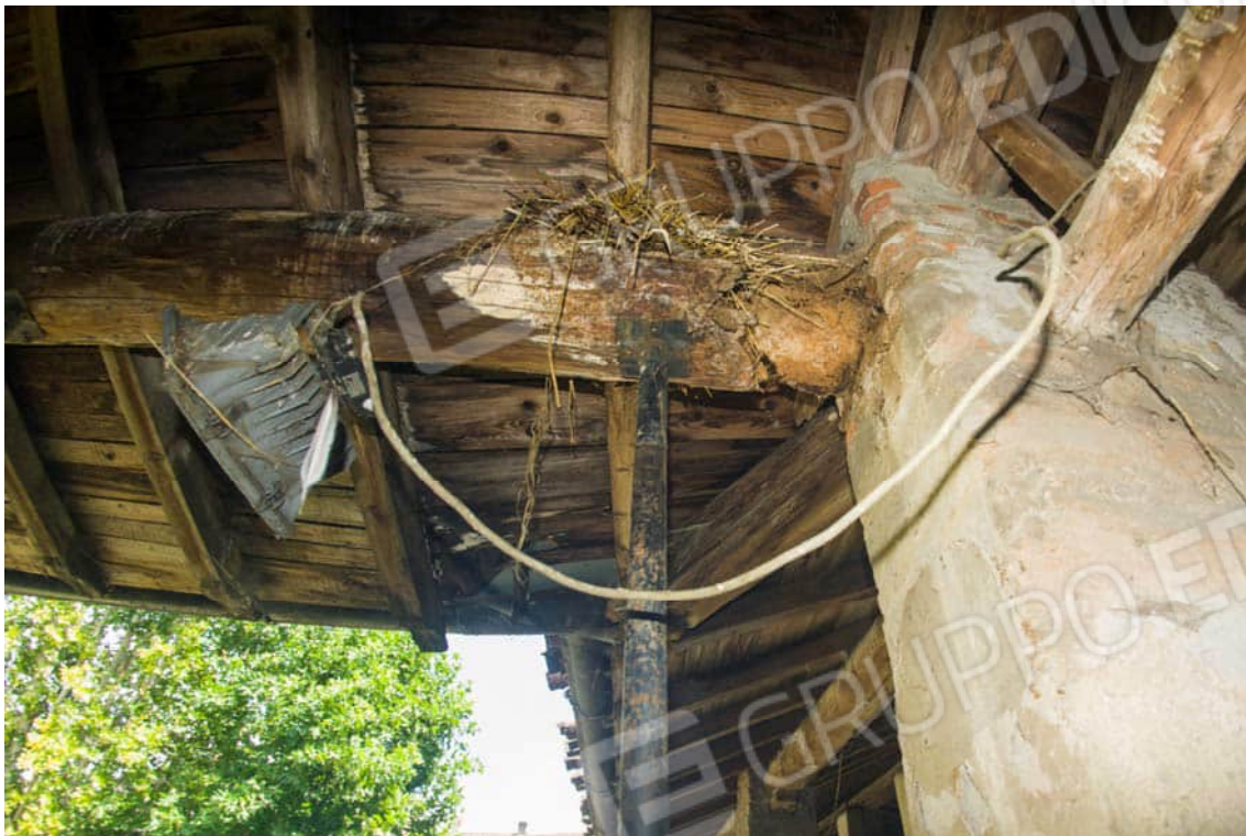
Trave in legno spezzata e tegole sporgenti oltre il canale di gronda
