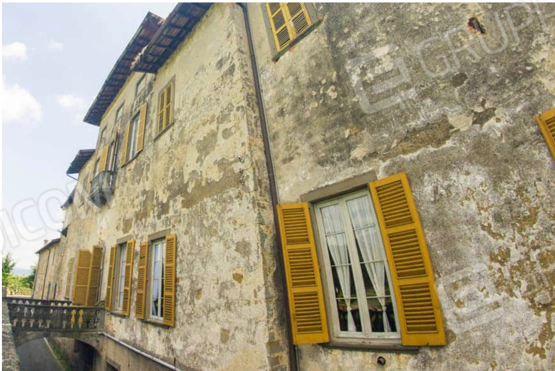
Facciata lungo la via Villa Gromo, con intonaco ammalorato
