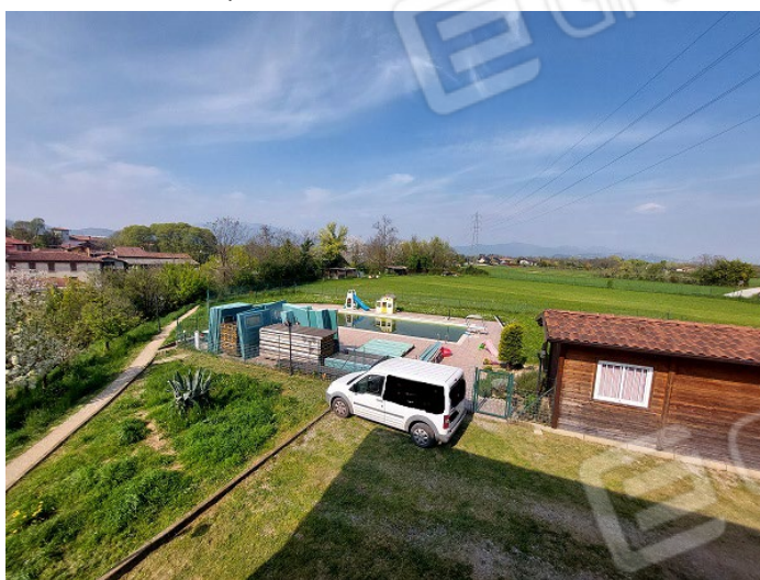
VISTA VERSO NORD OVEST
