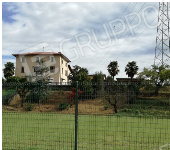
VISTA DA VIA SAN FRANCESCO D'ASSISI
