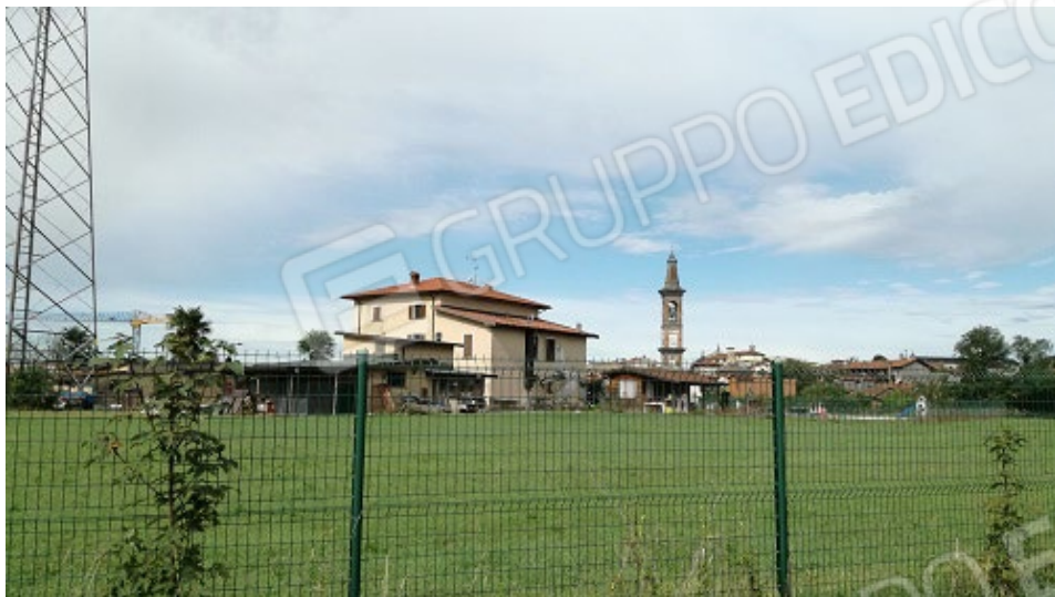
VISTA VERSO SUD OVEST DA VIA SANT'ALESSANDRO
