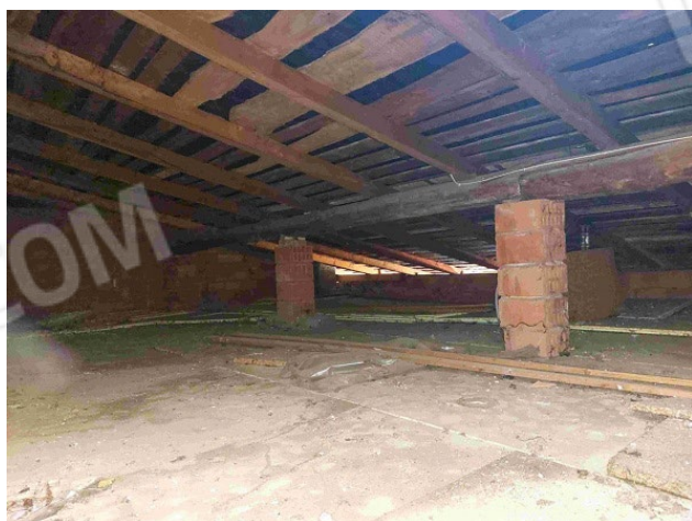
SOTTOTETTO NON ABITABILE
