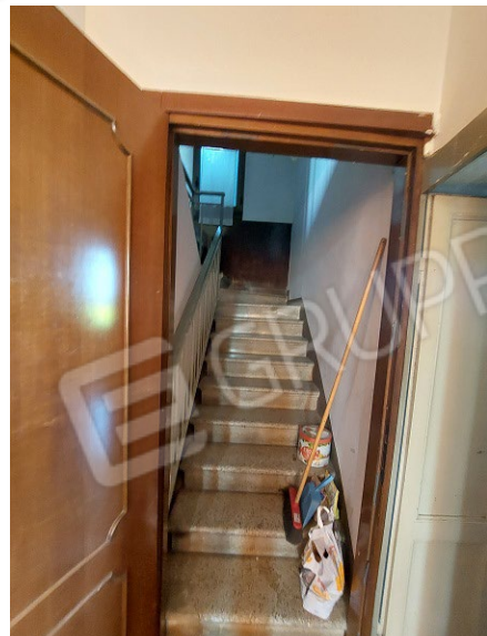
SCALA ACCESSO SOTTOTETTO
