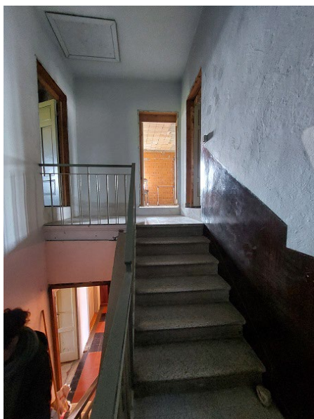
SCALA ACCESSO SOTTOTETTO
