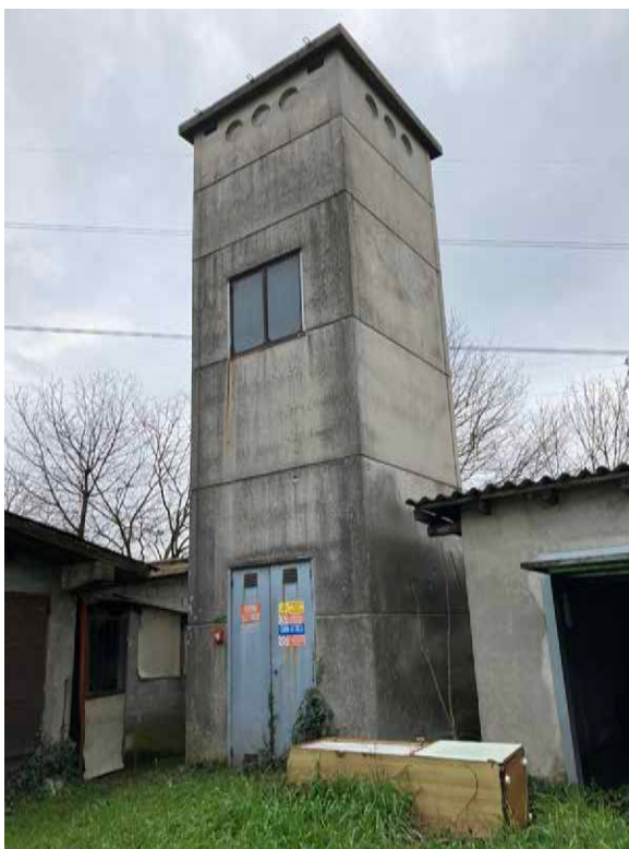
La cabina elettrica – CORPO C
