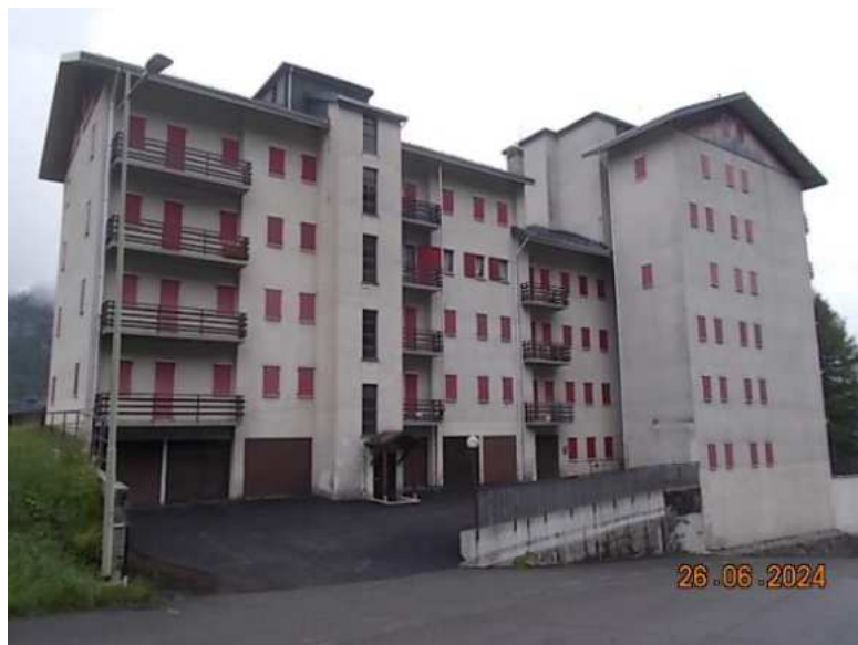
Fabbricato fronte nord
