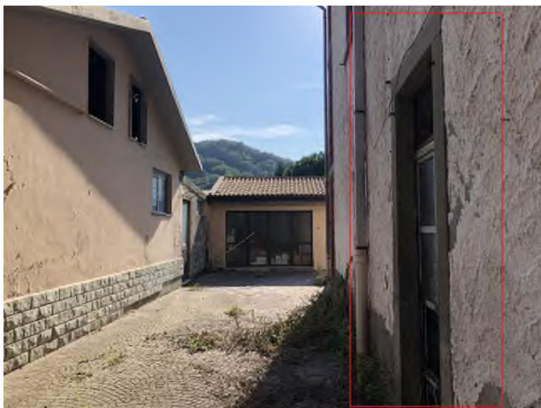
ingresso dal cortile
