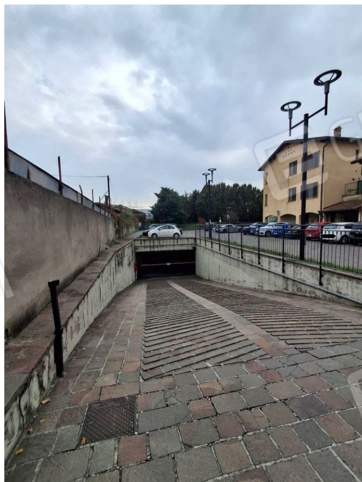
16) Rampa di accesso alle autorimesse
