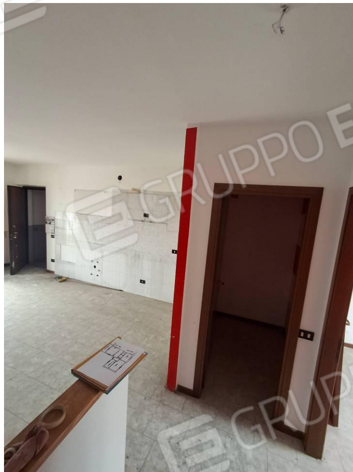
9) Veduta soggiorno e ripostiglio
