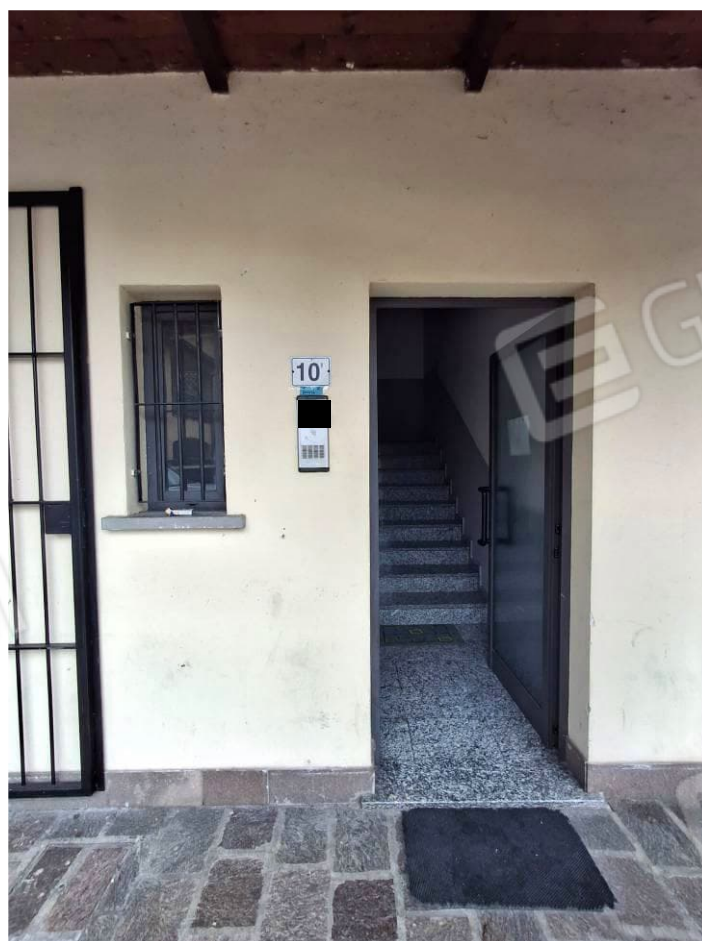
6) Veduta ingresso vano scale condominiale
