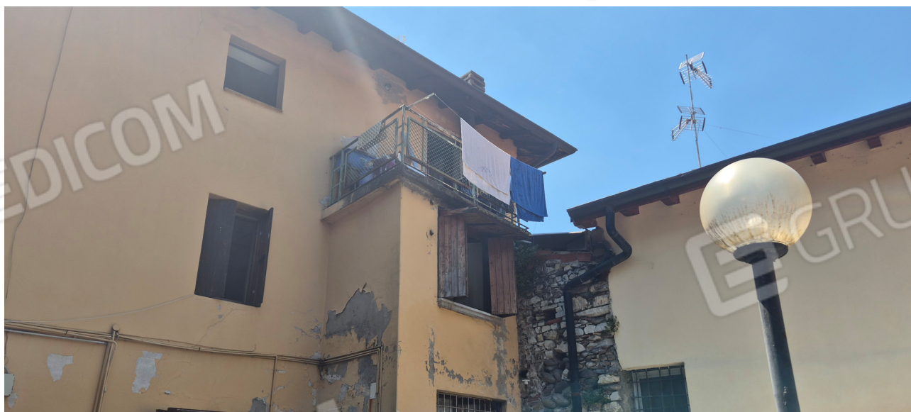
VISTA DAL CORTILE INTERNO
