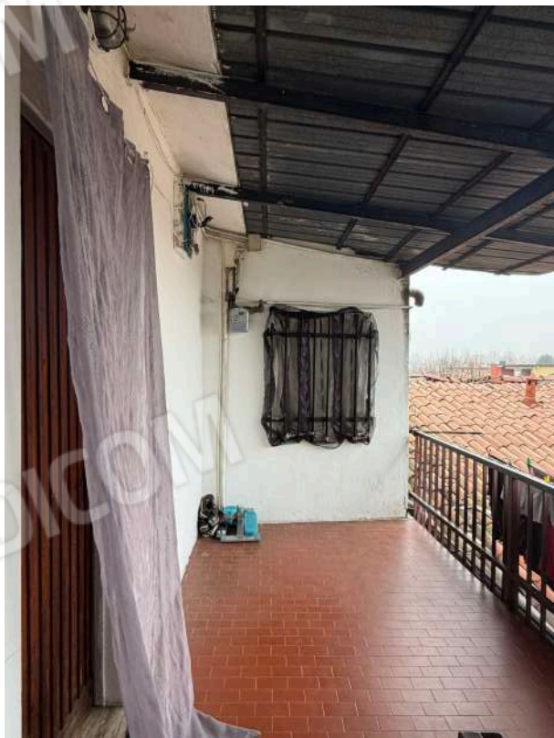
Pianerottolo di accesso all'immobile
