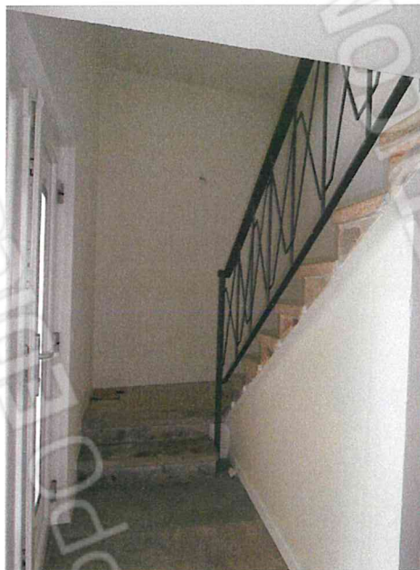
Foto 18 - Vano scala I rampa.JPG
