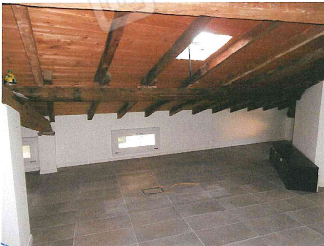
Foto 46 - Solaio angolo N-O.JPG
