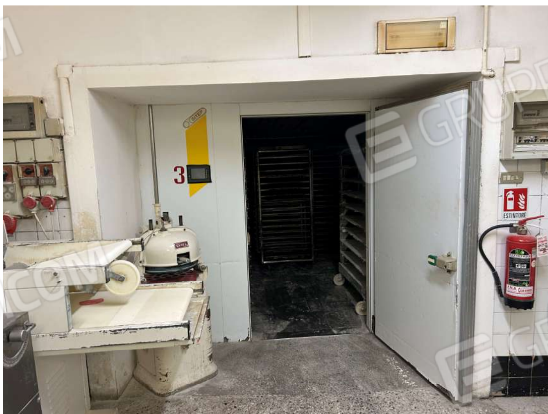
Foto 6 – Celle lievitazione sub. 703
