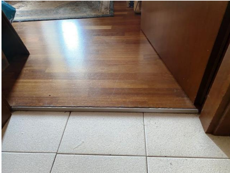
Parquet alla soglia della camera
