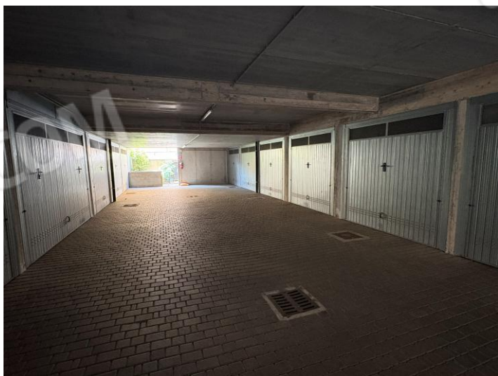
Viste corsello con autorimessa
