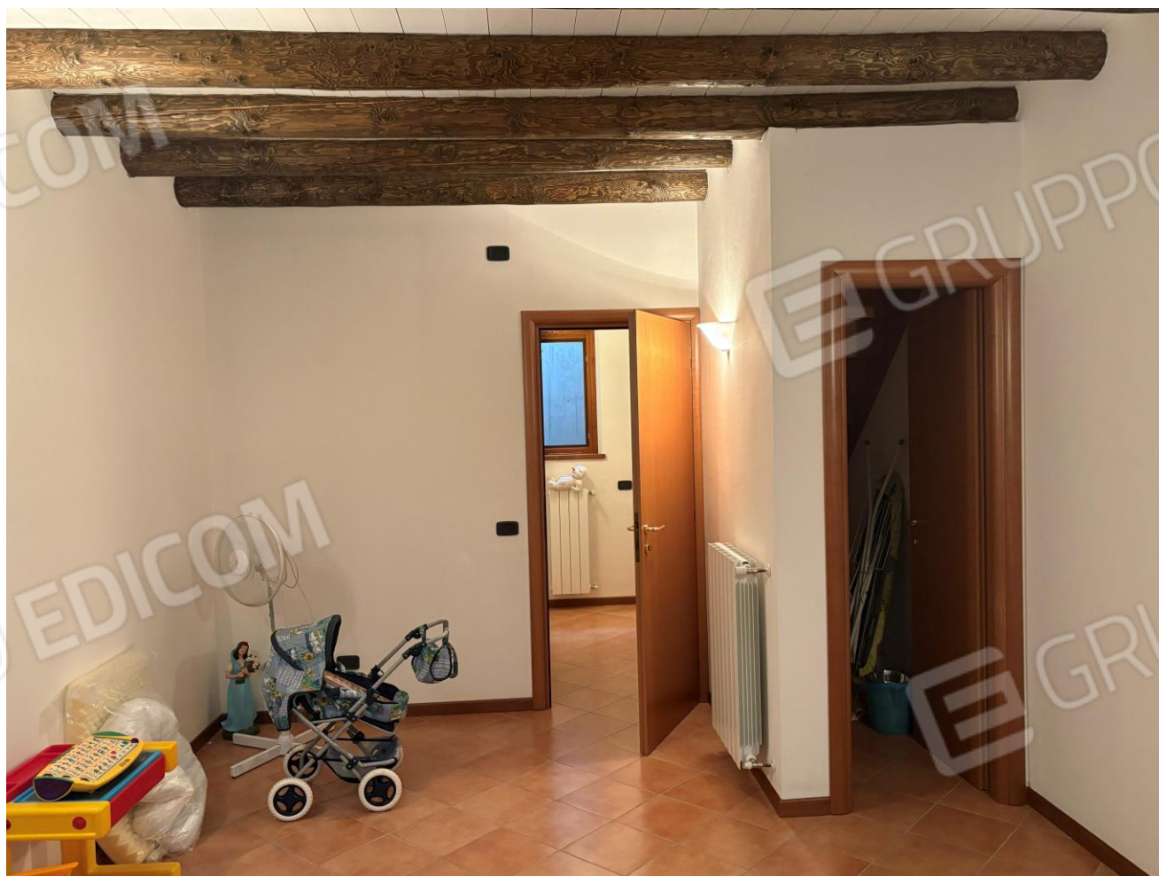
Vista locale al piano interrato
