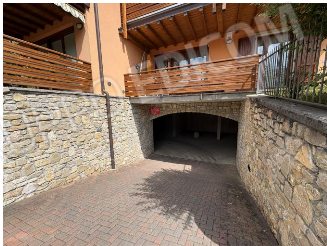
Vista ingresso autorimessa
